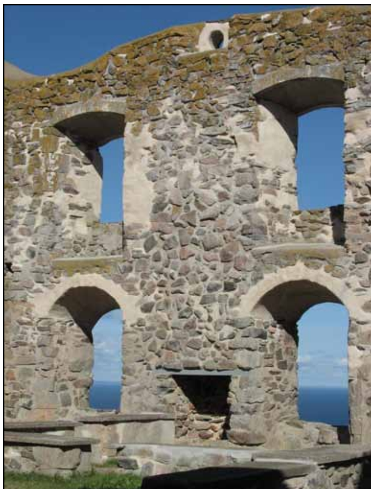
Norra murens insida före och efter arbetena. Tegel har som regel putsats över (i huvudsak modernt tegel, se nedan).
