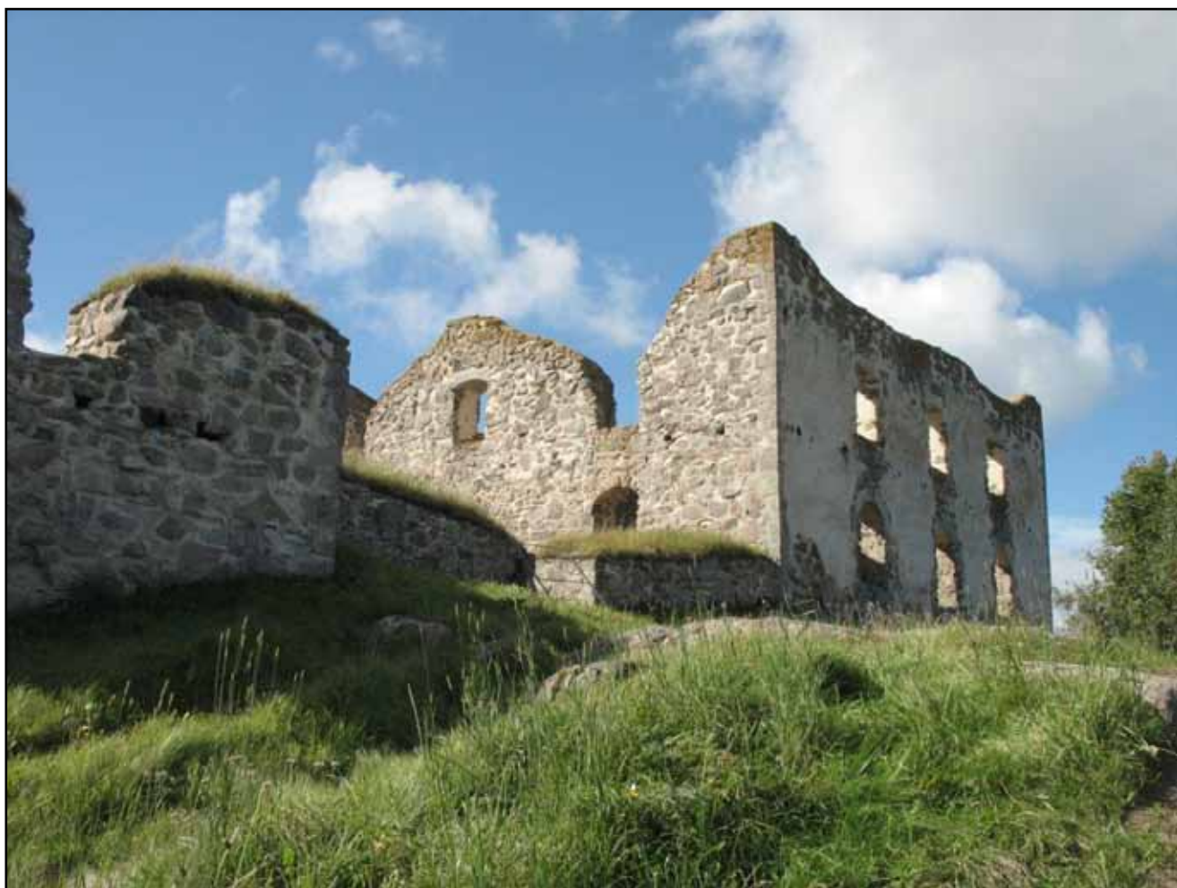
Slottsruinen från nordost efter avslutade arbeten. Borgårdsmurarna har plomberats med kalkbruk och bentonitlera samt täckts med enkla lager grästorv. Nordfasadens originalputs har säkrats.
