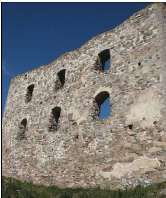
Södra fasaden efter avslutade arbeten. Stora partier omfogade med så långt möjlig bevarade originalfogar, tegelytor putsade och öar av originalputs säkrade.
