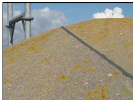
Dilatationsfog tätad med väderbeständig mjukfog.
