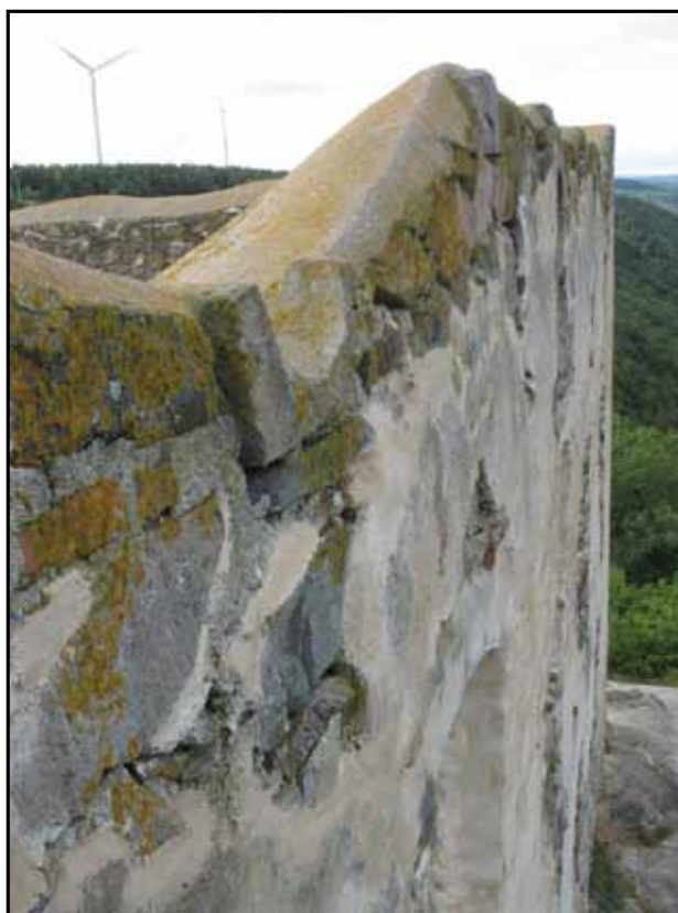
Övre putskant förseglad med kalkbruk på västra fasaden.
