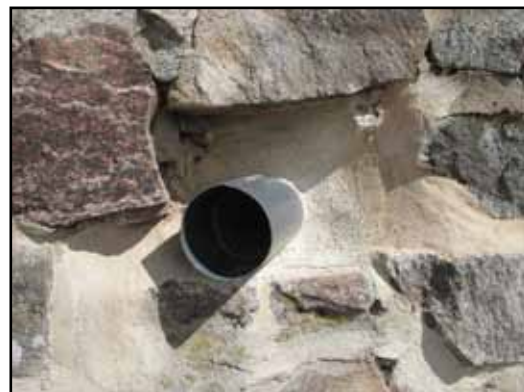
Nya dräneringsrör av plåt i huvudbyggnadens hörn.
