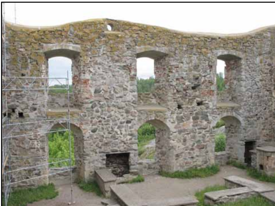
Norra murens insida före och efter arbetena. Tegel har som regel putsats över (i huvudsak modernt tegel, se nedan).
