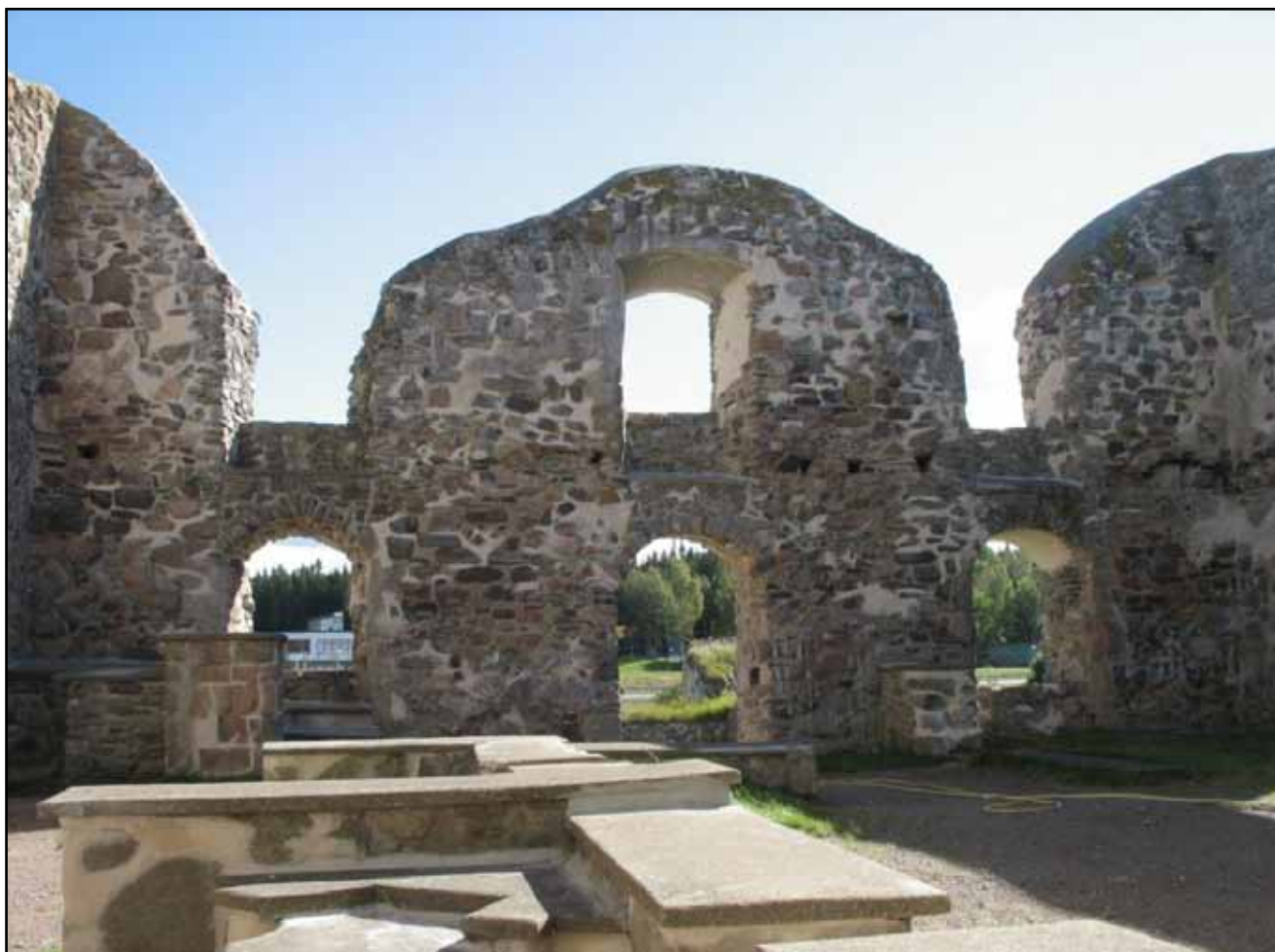
Östra murens insida. Ovan före arbetena, nedan efter. Till vänster ett av få partier i huvudbyggnaden som behövde muras om, i den södra av fönstersmygarna i andra våningen. Även resterna av mellanväggarna i huvudbyggnaden reparerades.
