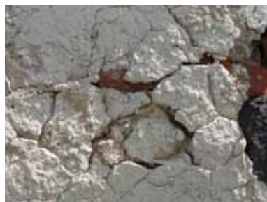
FRÅN VÄNSTER TILL HÖGER: VITTRANDE PUTS (3), UTSTÅENDE SPJÄLKANDE PUTS (8) OCH ERODERAD/URGRÖPT PUTS (9).
