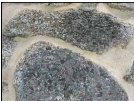
Exempel på omfogningsarbete. Äldre fogar med gott fäste bibehölls.
