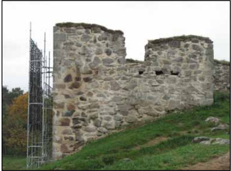
Norra tornet från norr efter avslutade arbeten.
