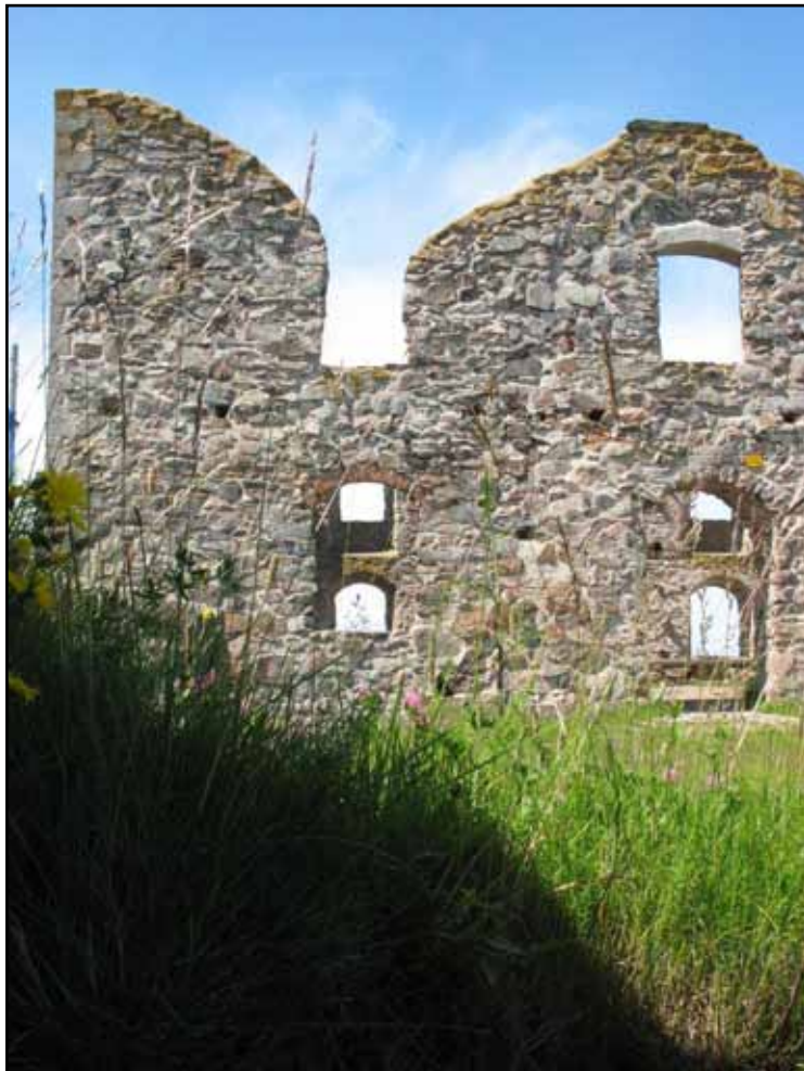
Huvudbyggnadens östra fasad före arbetena.
