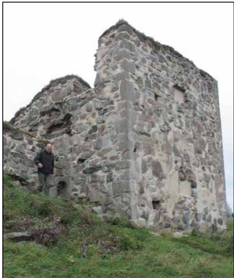
Södra tornet från sydväst efter avslutade arbeten. Tomas Areslätt från länsstyrelsen inspekterar.
