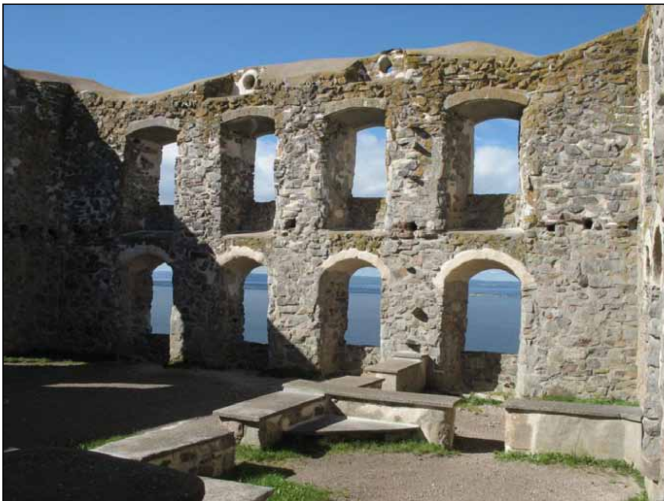
Västmurens insida och mellanväggarna efter avslutade arbeten.
