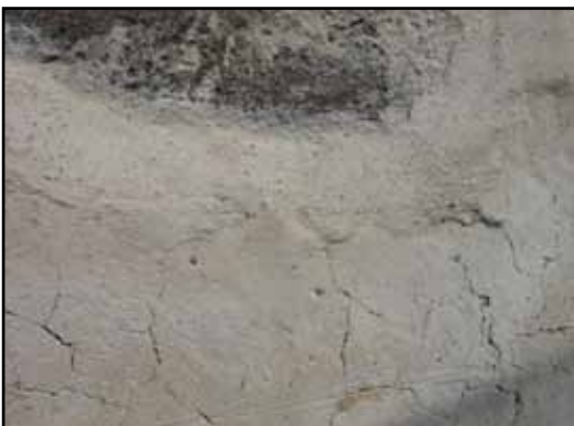
Kant på originalputs plomberad med kalkbruk. Allt fog- och putsbruk pigmenterades i överensstämmelse med originalbruket.
