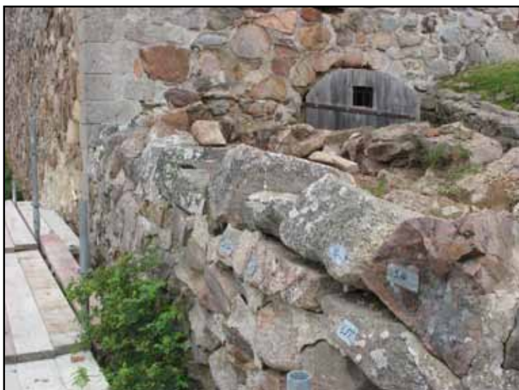
Stenarna i södra borggårdsmuren övre skift uppmärkta inför demontering och återuppmurning.
