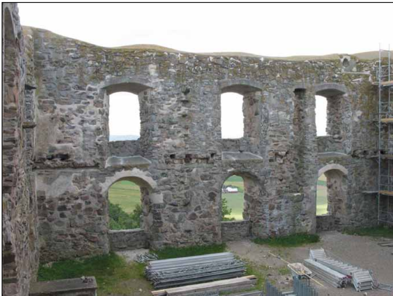
Sydmurens insida efter avslutade arbeten.
