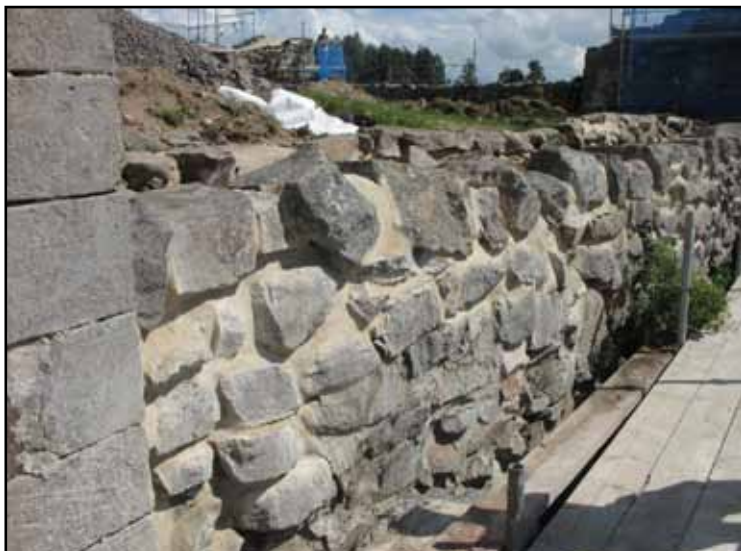
Övre delen av yttre skalmuren på södra borggårdsmuren åtgärdad genom nedplockning och återuppmurning.
