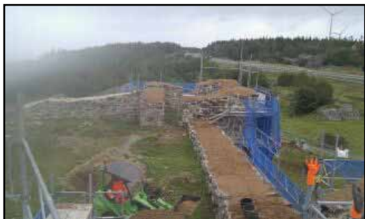
Plombering av borggårdsmurarnas krön med bentonitlera ovanpå bruksavjämning med kalkbruk. Foto: Magnus Ekenäs, Svevia.
