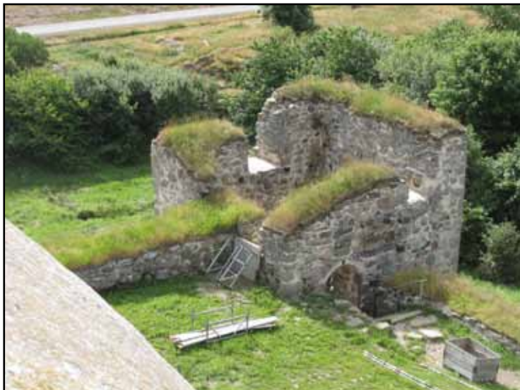
Ovanpå bentonitleran lades slutligen tätvuxen grästorv.
