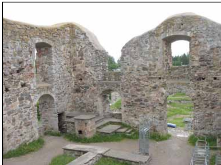
Östra murens insida. Ovan före arbetena, nedan efter. Till vänster ett av få partier i huvudbyggnaden som behövde muras om, i den södra av fönstersmygarna i andra våningen. Även resterna av mellanväggarna i huvudbyggnaden reparerades.
