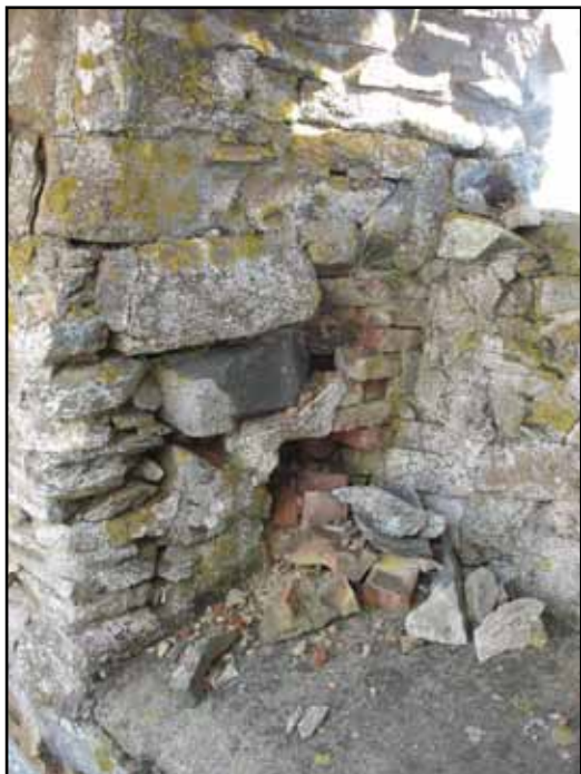
Östra murens insida. Ovan före arbetena, nedan efter. Till vänster ett av få partier i huvudbyggnaden som behövde muras om, i den södra av fönstersmygarna i andra våningen. Även resterna av mellanväggarna i huvudbyggnaden reparerades.
