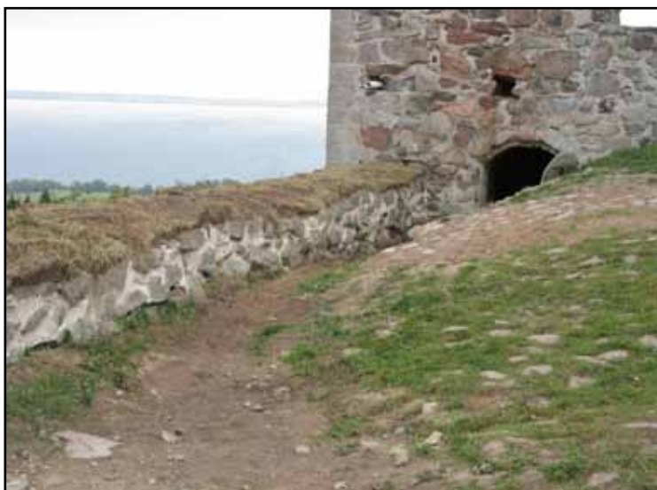
Södra borggårdsmuren efter avslutade arbeten. Murkrönet plomberat med bentonitlera ovanpå vilken lagts grästorv. Stenläggningen på borggården återställd med nytt material.
