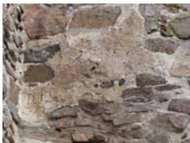
OVAN TILL VÄNSTER. FÖR ATT SÄKRA PUTSEN PÅ INSIDAN AV ÖSTRA VÄGGEN FICK LAGNINGSBRUK FÖRAS IN MED SPATEL MELLAN PUTS OCH MUR.
