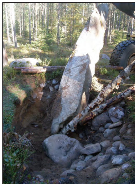
FIGUR 7. Mittstenen styrs på plats med hjälp av massavedsbitar som styrhjälp.
