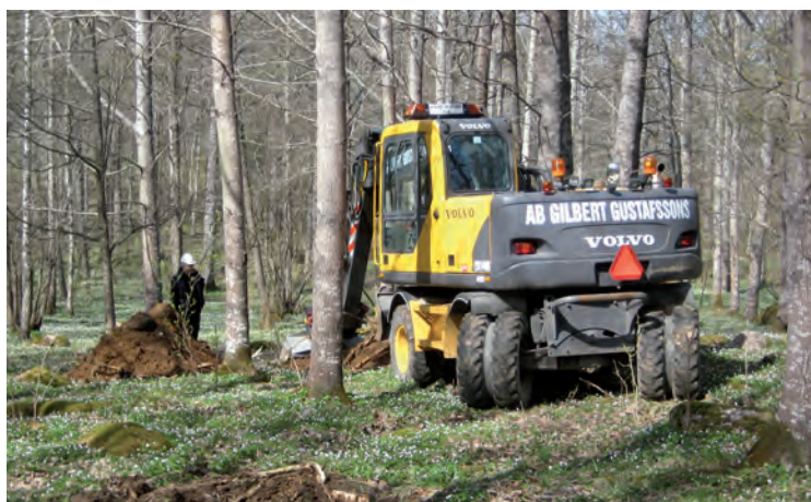
FIGUR 7. Efter en del mindre röjningsarbeten kunde schaktningen påbörjas.
