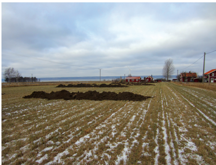
FIGUR 2. Översiktsbild efter schaktning, från öst. Foto: J Borg.
