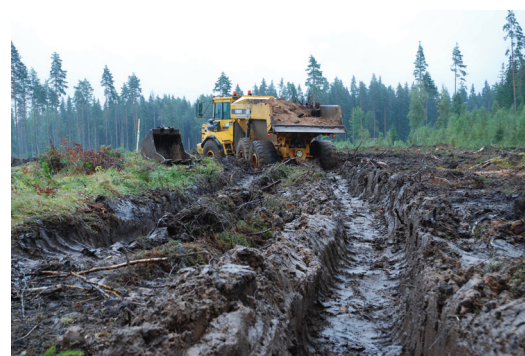
FIGUR 3. Den fuktiga väderleken skapade problem med att få bort massor från undersökningsytan, varför en dumperväg gjordes. Foto Fredrik Engman.
