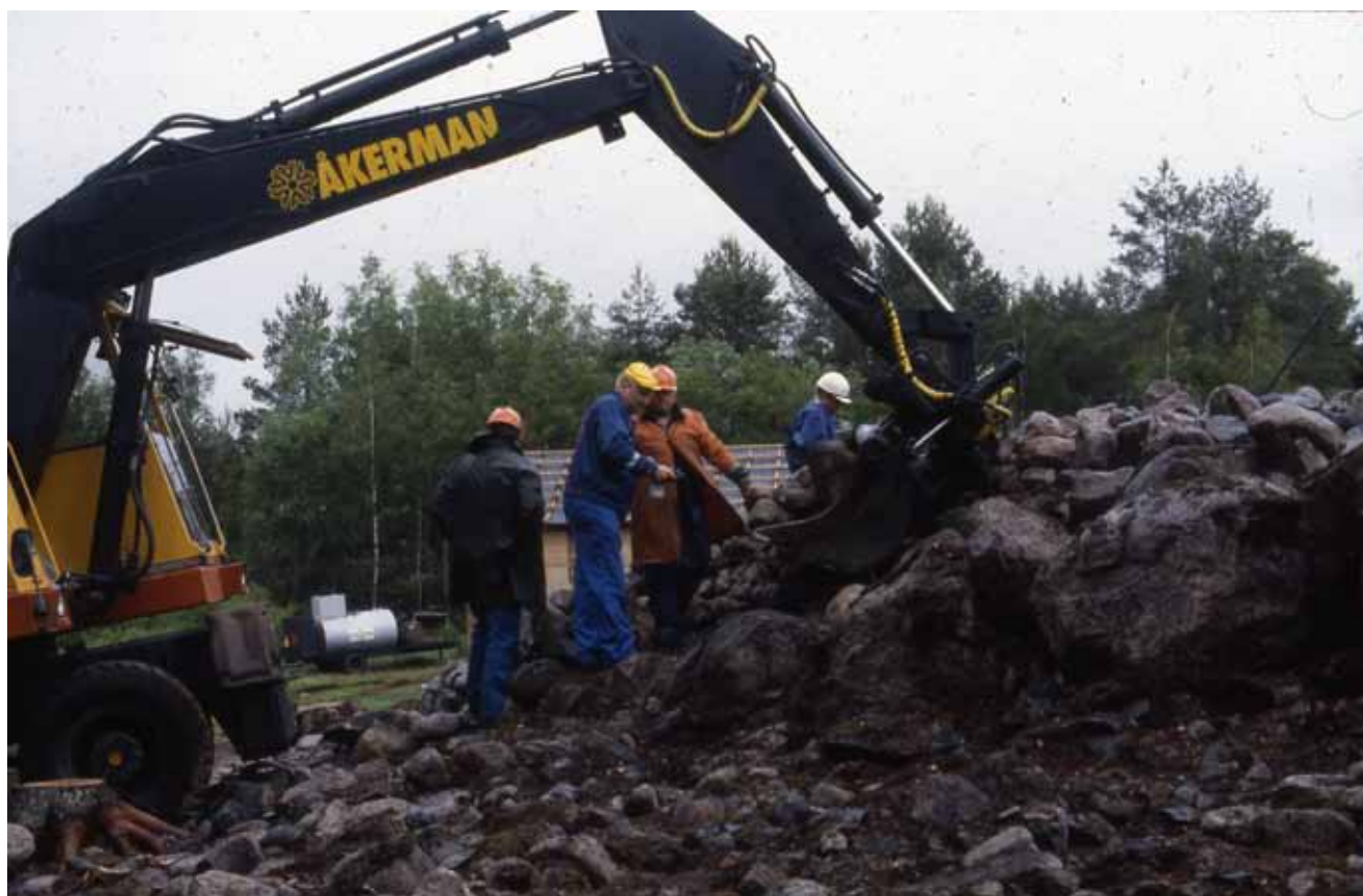
FIGUR 23 OCH 24. Rensningsarbetet och bortplockning av sten med hjälp av grävmaskin.
