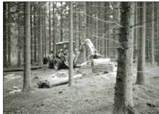
FIGUR 8. Grävning av långschakt inom delområde 1. Foto Fredrik Engman.
