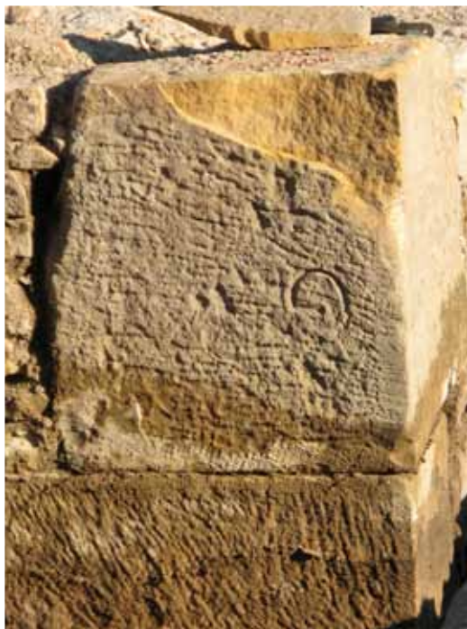
FIGUR 48. Sandstenskvader inne i den västra kasematten. På blocket syns ett stenhuggarmärke i form av ett G.
