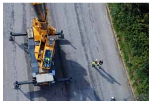
FIGUR 14. Kranfoto på Västra kajen. Bastionen dokumenteras från 30 m höjd.
