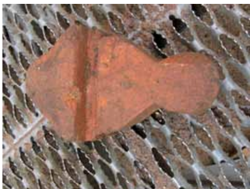
FIGUR 64. Medeltida profiltegel, avsett för mittstolpen i ett gotiskt fönster.
