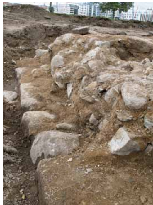
FIGUR 42. Den noga nedbrutna fasaden på bastion Carolus norra flank. Bara syllstenarna och murkärnans nedersta del har lämnats in situ.
