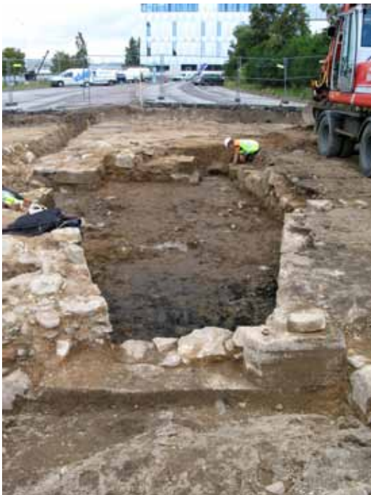
FIGUR 34. Den västra kasematten med embrassyren och dess kanonport. Notera den fint avfasade karmstenen.
