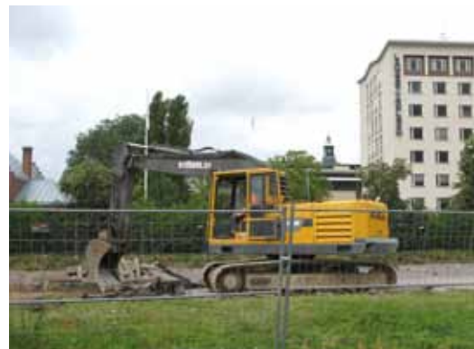
FIGUR 7. Grovschaktning inleds med att bryta upp asfalt.
