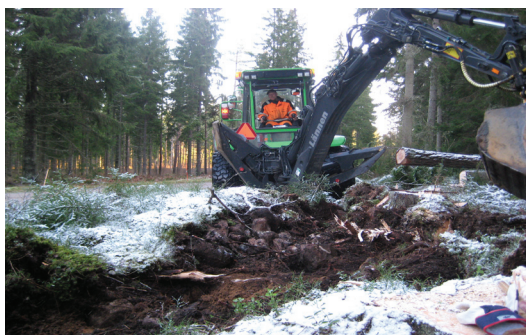
FIGUR 3. Grävmaskinen i arbete. Foto: Anna Ödeén.
