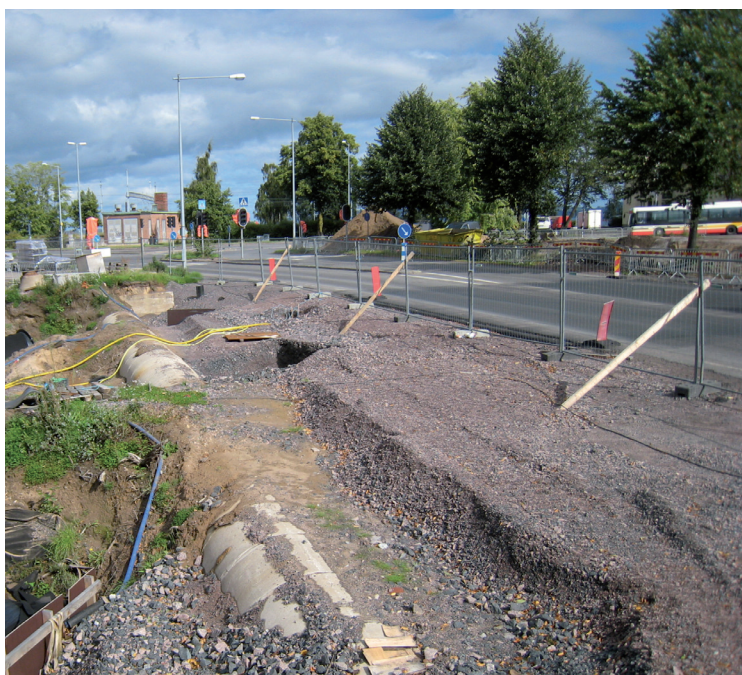
FIGUR 5. Här syns det som är kvar av Junebäcken idag, i det aktuella området, kulverterat i den trumma som bäcken numera rinner i fram till Vättern. Den gamla pumpstationen syns i fjärran. Foto från söder.
