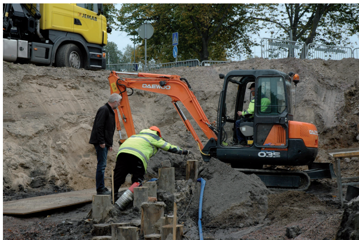
FIGUR 12. För att kunna schakta de sista lagren i botten måste en mindre grävare lyftas ner i schaktet för att komma åt, utan att riskera att schaktkanterna rasade, då schaktdjupet var mellan 3 och 4 meter.
