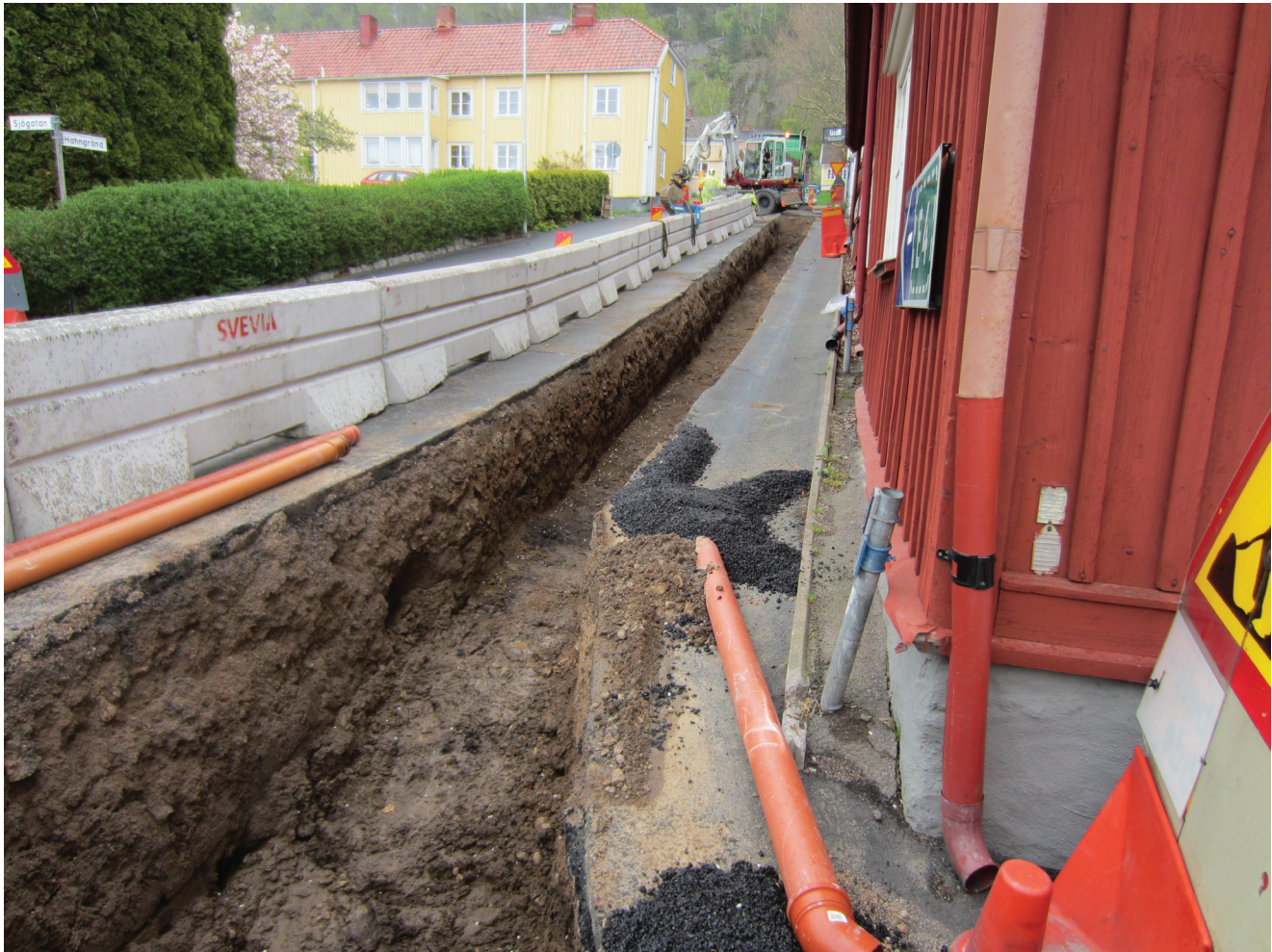
Hahngränd sett från Sjögatan med ingången till gården i kvarteret Vålviljan uppe vid grävmaskinen. Det mörkare kulturlagret synligt i botten av schaktet i förgrunden.
