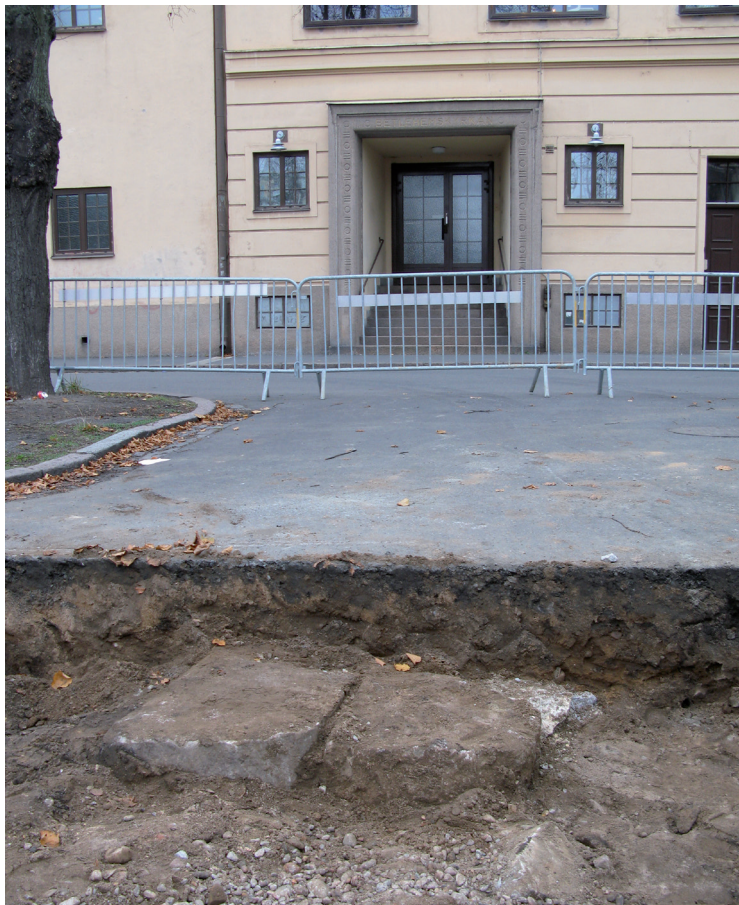
FIGUR 6. Det påträffade brofundamentet i den norra delen av schaktet. Dessa huggna stenar har sparats under den nya vägbeläggningen. Foto mot norr med den västgående filen av Kanalgatan.
