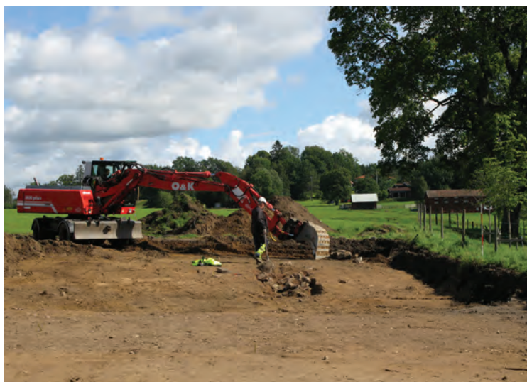
FIGUR 32. Hus 2 - husplatsen under framschaktning. Hålvägen A519 syns som en tydlig svacka,; i dess bottenkant ligger ugnen A655.
