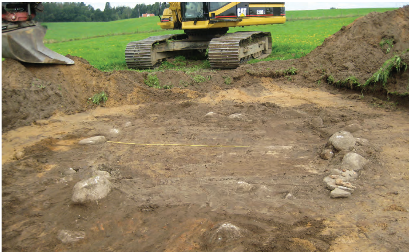
FIGUR 39. Hus 4 - Källarnedgrävning med rester av stensyll, eventuellt också synliga stenar från kallmurade källarväggar. Foto (2007): Jan Borg, JLM.
