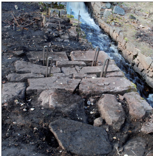
FIGUR 4. Fundament och fästband i järn för stångjärns-hammaren.
