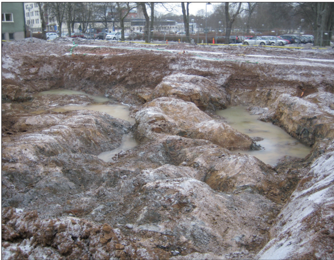
Det stora schaktet i början av februari.
