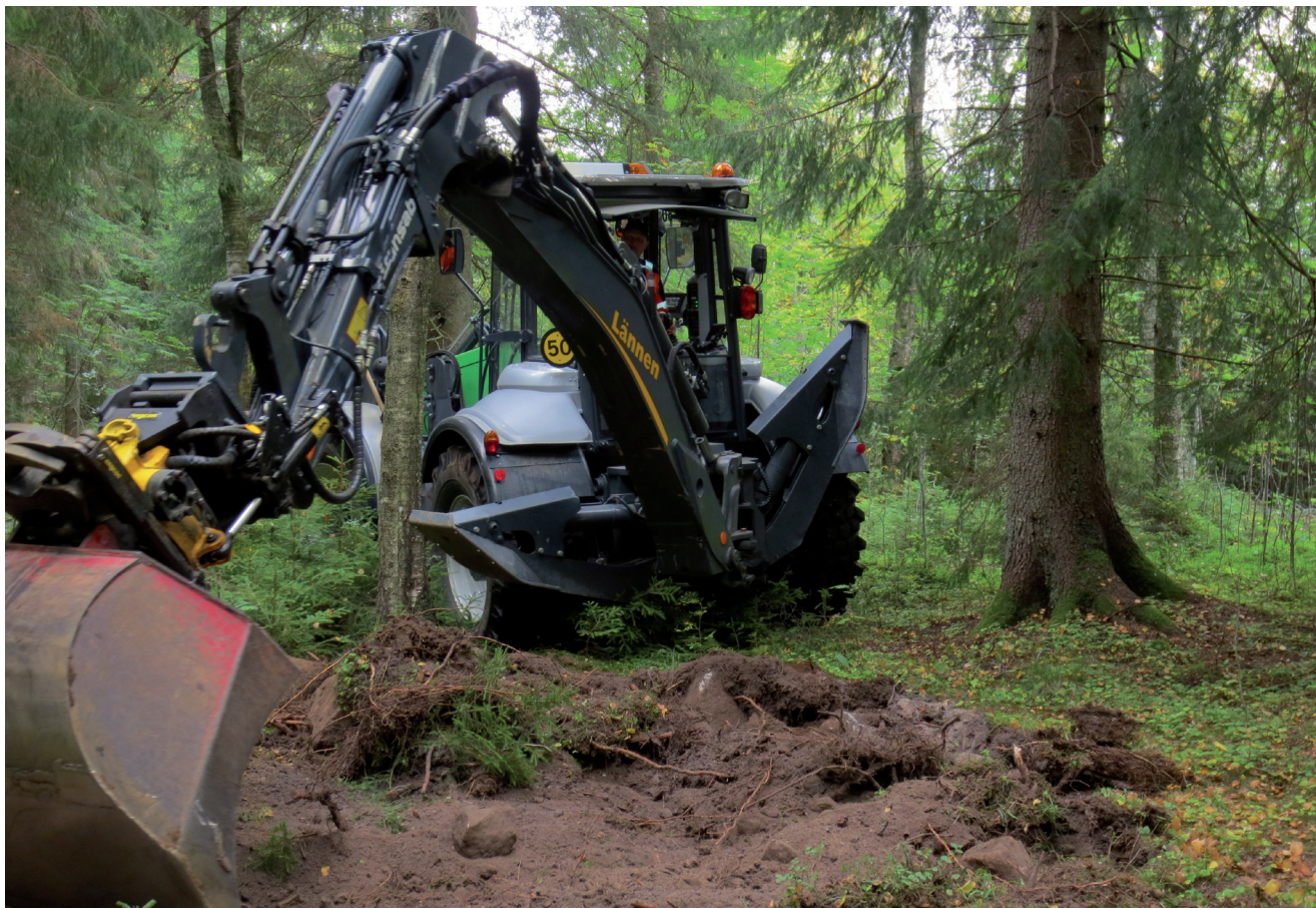
FIGUR 2. Sökschaktning i skogen.
