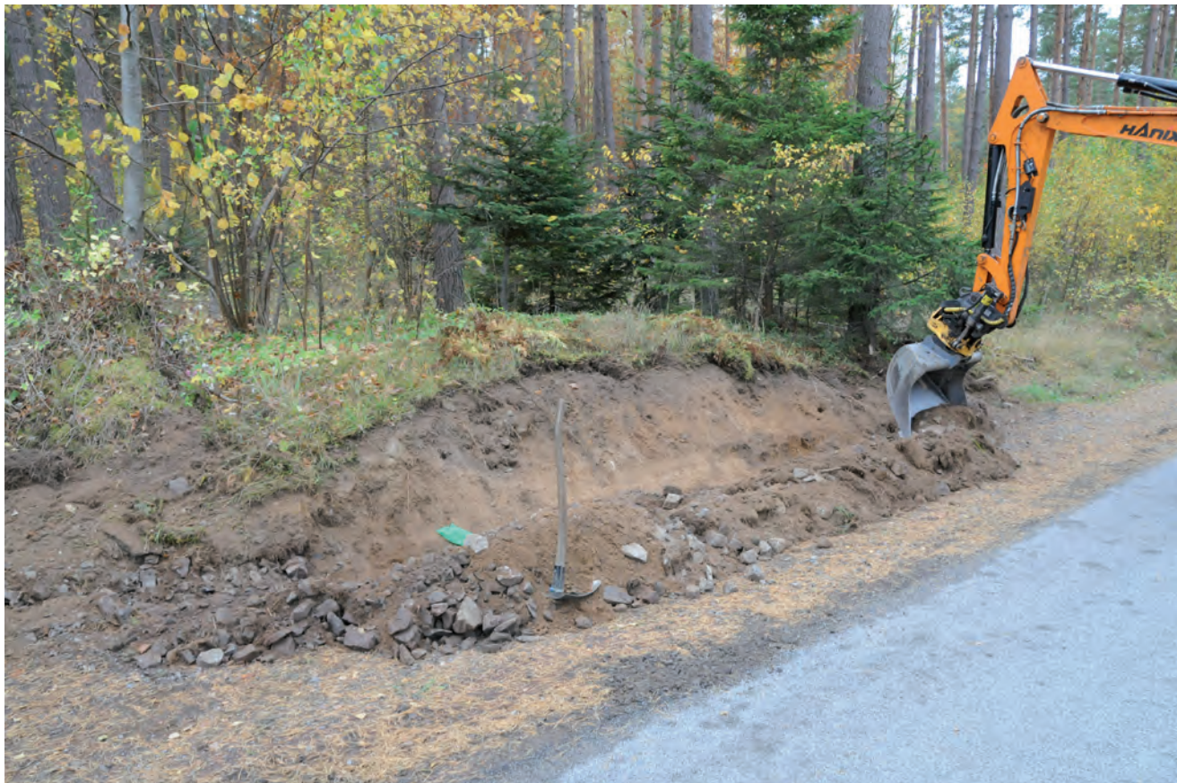
FIGUR 5. Pågående arbete med rensning av profilen..
