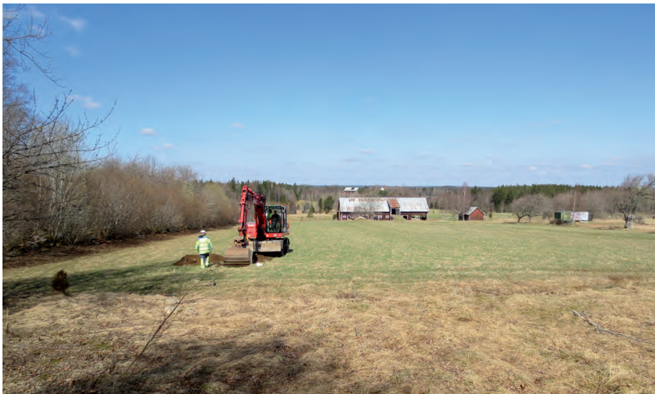
FIGUR 2. Sökschaktningen startas upp.
