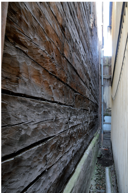
FIGUR 5. Den smala vreten mellan gatuhuset i kv. Bägaren 2 och 3 inför utläggning av signalkabel.
