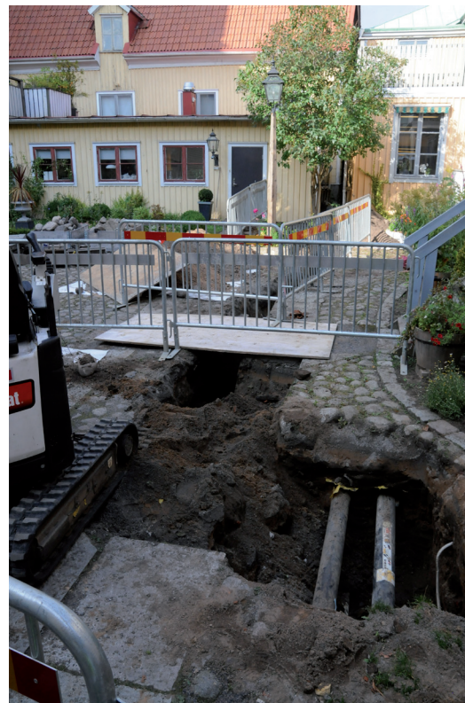
FIGUR 2. Innergården till fastigheterna kv. Bägaren 2 och 3, en arbetsplats präglad av komplicerad logistik.
