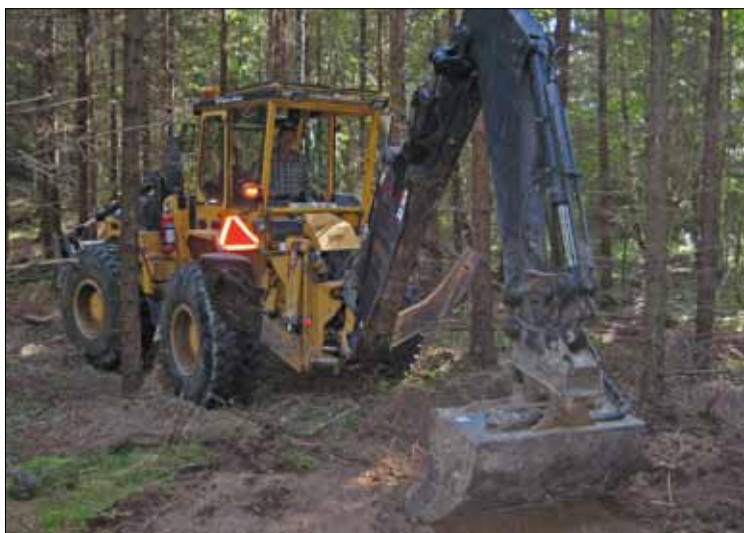
FIGUR 3. Schaktning i skogen intill Bredestad 53:1.
