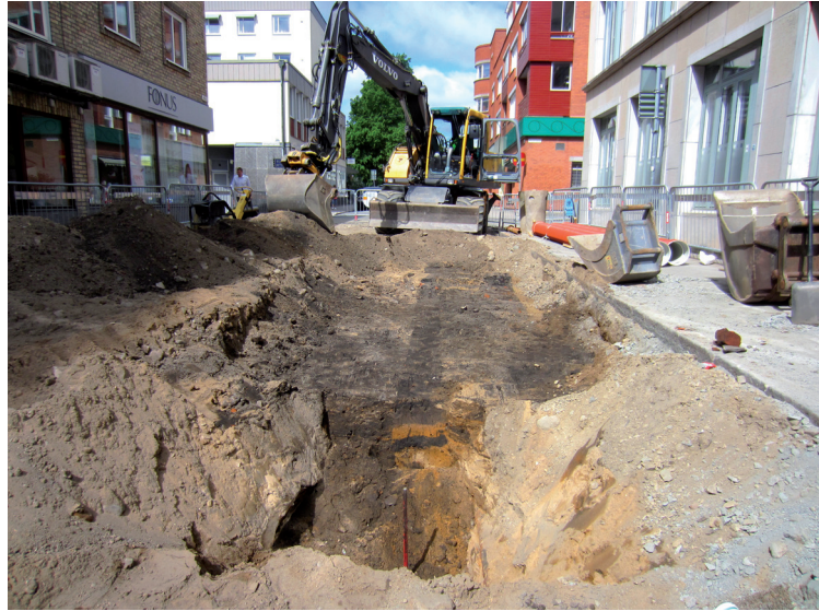
FIGUR 7. Översikt av ledningsgrävning. I Nygatans mitt är remsor med kulturlager (svarta skikt) avskurna av äldre ledningsschaktningar. Foto från öst.
