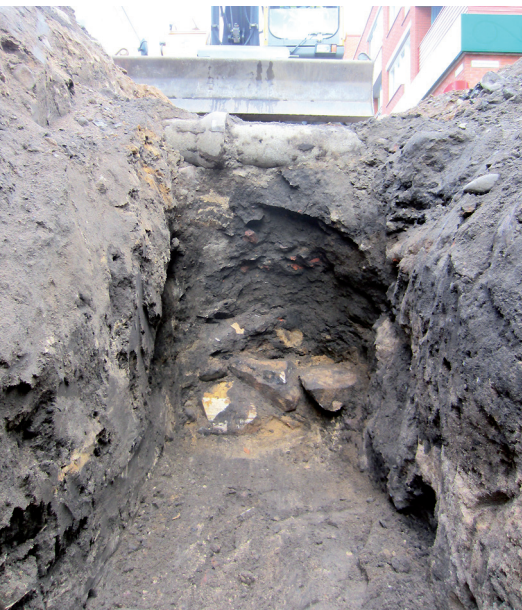
FIGUR 15. Schaktet för dagvatten har grävts igenom del i raseringslagret A5 och kommit fram till en trumma med kablar. Därunder framkom 1,4 meter under markytan sandstenar vilka tolkades som rest efter grund till källare.
