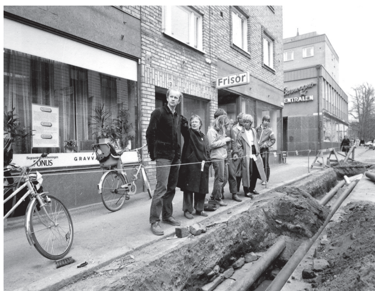
FIGUR 3 Schaktning för fjärrvärme på Nygatan 1983. I schaktet framför åskådarna på bilden skymtar intill fjärrvärmerören stenar till trappa som leder ned i en källare vilken ingått i medeltidsstadens bebyggelse. Endast en mindre del av trappan kunde dokumenteras i det smala schaktet. Trappan framkom 1,4 meter under nuvarande Nygatan (nr 13). Foto från öst.
