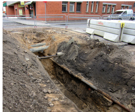
FIGUR 8. Översikt av det smala ledningsschaktet för dagvatten i Nygatan mot korsningen Västgötagatan. I norra schaktväggen syns ett svart raseringslager vilket innehöll bl.a. sandstenar och fragment av stortegel (A5). Under trumman med elkablar låg en rad sandstenar (A6). Längre bort är fjärrvärmerör vars schakt har genomskurit en källare. I förgrunden syns ett rostigt järnrör till gasledning som löper i samma riktning som dagvattenschaktet. En äldre gasledning var anlagd på en knapp meters djup och skar genom det svarta lagret. Foto från sydöst.
