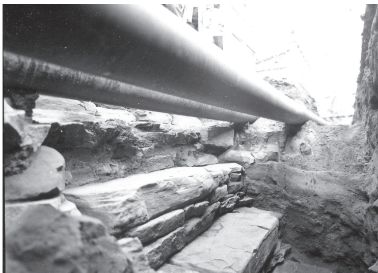
FIGUR 5. Källartrappa påträffad vid grävning för fjärrvärme 1983 i Nygatan (nr 13). Anläggningen framkom 1,4 meter under dagens gatunivå. Lämningen kunde inte undersökas på djupet i det smala schaktet och fick kvarligga i orört skick efter framrensning och dokumentation. Fjärrvärmerören lades ovanpå trappan, utan ingrepp i anläggningen. Foto från sydöst.
