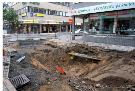
FIGUR 2. Översikt som situationen var vid förundersökningens inledande skede. Schakt för dagvattenledning knappt två meter djupt under Nygatans östra del mot Barnarpsgatan. I bakgrunden skymtar tillfälligt framgrävda fjärrvärmerör, anlagda 1983. Foto från nordväst.
