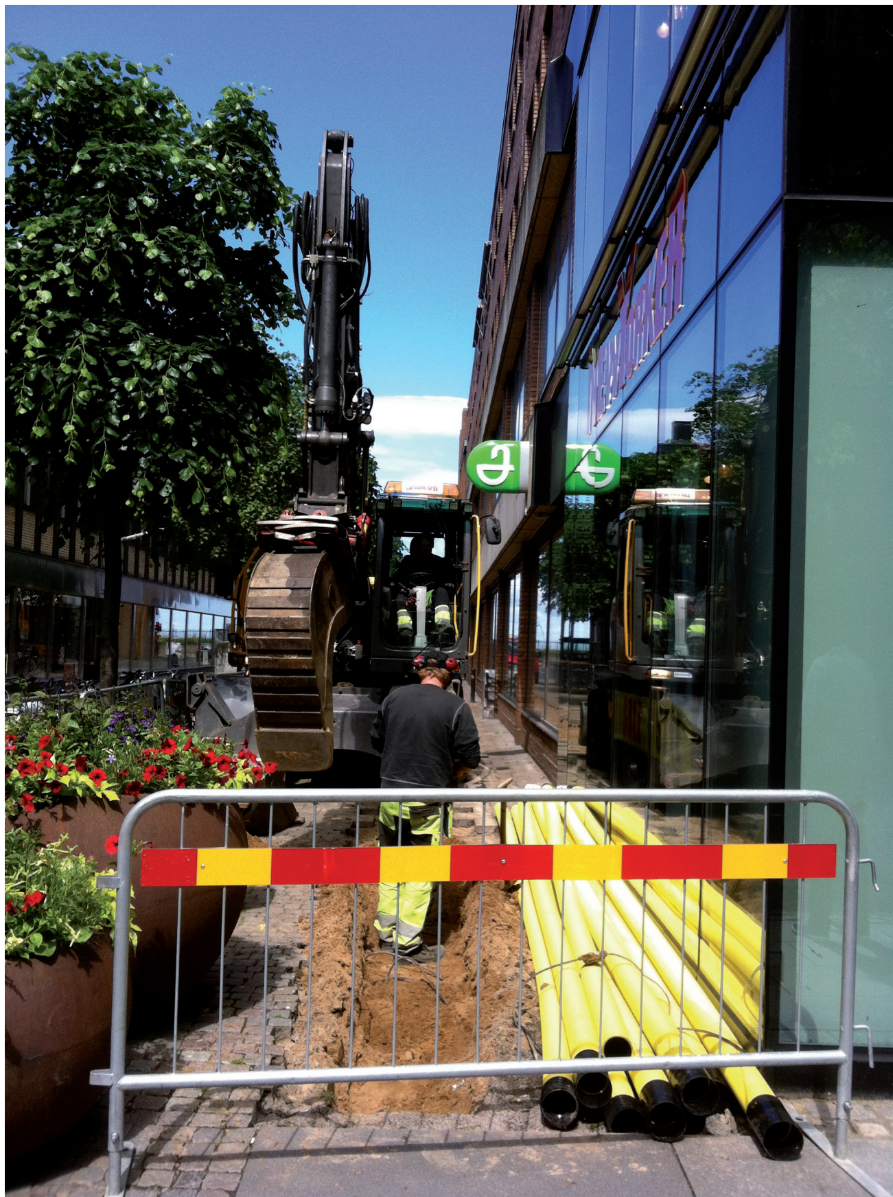
Schaktning påbörjad i södra delen av Bredgränd.
