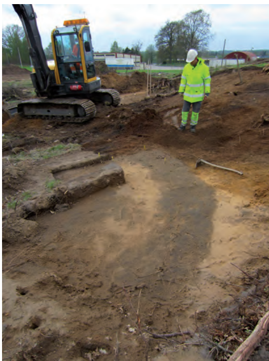
FIGUR 23. Sakta växer kantrännan från den bortplöjda högen A2011 fram vid schaktning.
