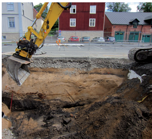
FIGUR 4. Samma brygga som föregående bild. Här syns läget på anläggningen A1. Foto från väster.
