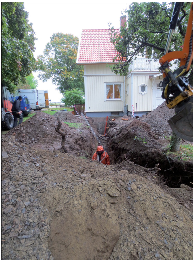
FIGUR 11. Schaktningsarbetet närmast husen.
