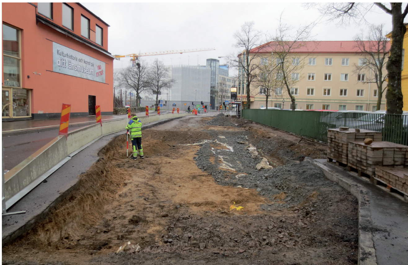
FIGUR 5. Inmätning av kanalens stenskoning. I fonden syns det nyligen uppförda parkeringshuset i kvarteret Atollen. Nedan i figur 6 ligger båtar vid den dåvarande kajen i Munksjön. Foto Mikael Nordström, Jönköpings läns museum.
