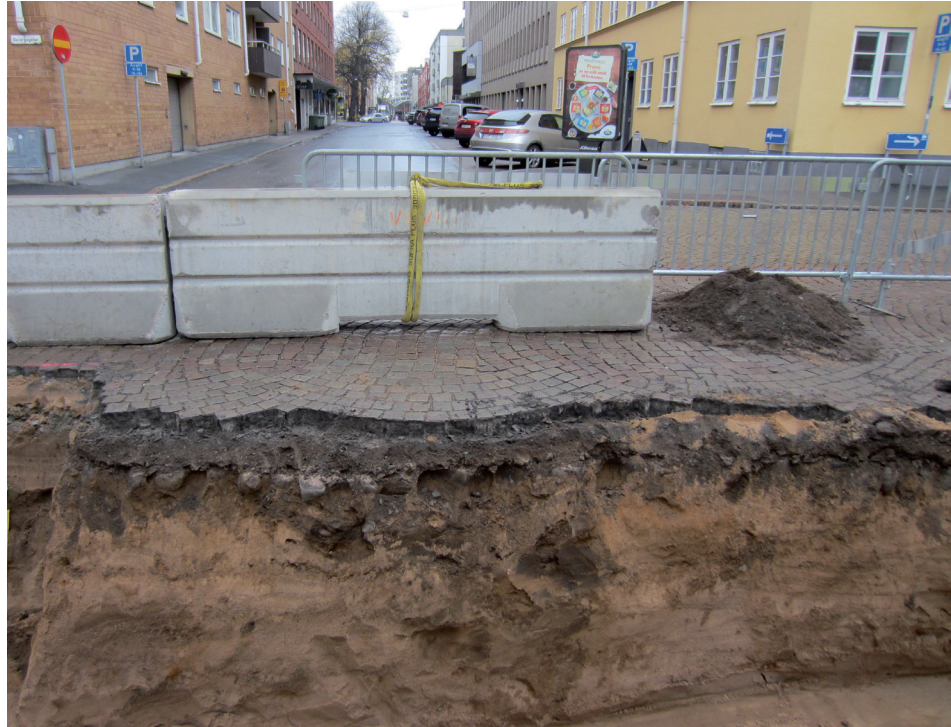
FIGUR 4. Schakt längs Oxtorgsgatan/ Trädgårdsgatan med nedgrävningen i den norra delen av schaktet.
