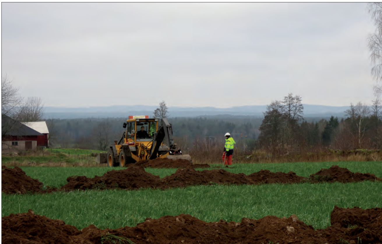
FIGUR 12. Arbetsbild, sökschaktning inom BL006.
