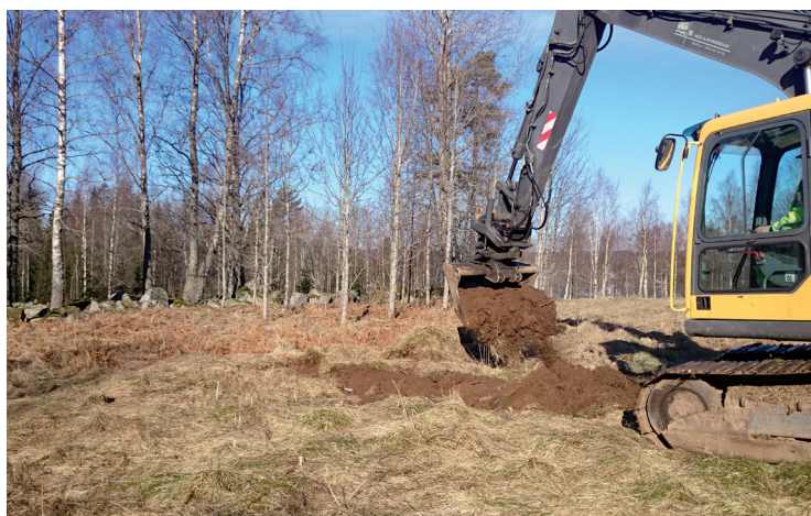
FIGUR 2. Arbetsbild. Sökschaktning i norra delen av ID8.
