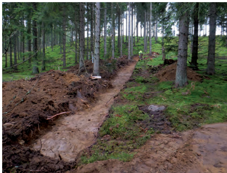
FIGUR 6. Undersökningsområdets västligaste begränsning med schakt 2 beläget i kraftigt sluttande terräng..
