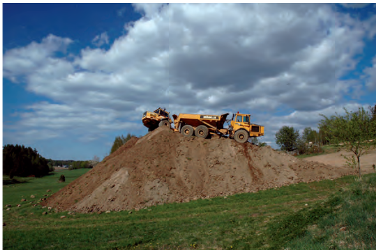
FIGUR 8. Dumphögen vid det södra området under framväxt.
