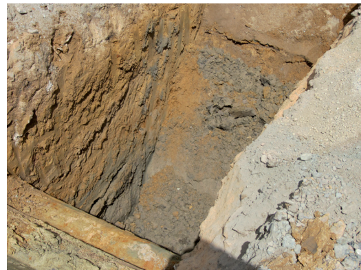
FIGUR 9. Schakt 29 med sin lerblandade sand mot botten.
