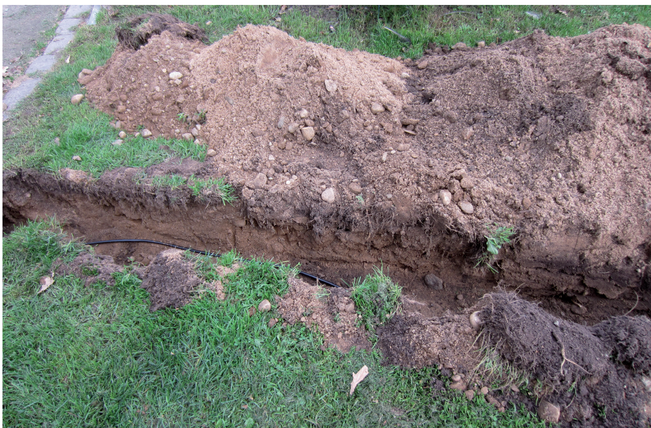
Bild under: det grunda schaktet, 0,2-0,3 meter djupt, genom matjorden
