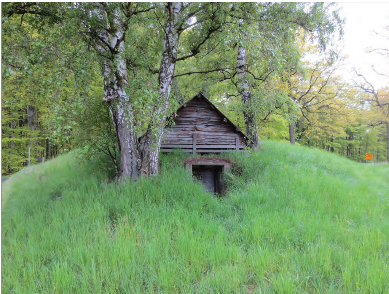
FIGUR 13. Grav 286 på södra gravfältet med inbyggd källare.
