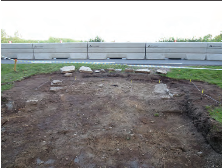
FIGUR 4. Avbanad yta och avspärningen mot landsvägen. Foto från öster.
