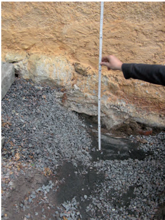
FIGUR 16. Terrassmurens läge vid huvudbyggnadens norra gavel. Även här finns ett tydligt, ungefär meterhøgt skilje mellan en slät dagermur och en rå muryta som aldrig varit avsedd att synas. Foto: Claes Pettersson, JLM.
