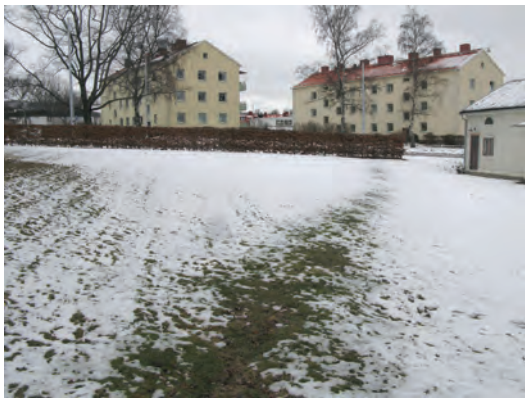
FIGUR 11. Fjärrvärmeledningarnas olyckliga dragning diagonalt över 1700-talets stensatta gårdsplan framträdde tydligt i det tunna snötäcket den 8 mars 2016. Foto: Claes Pettersson, JLM.
