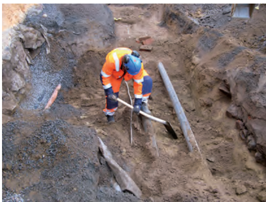
FIGUR 12. Det 3,6 meter breda schakt för fjärrvärme som grävts genom gårdsplanen söder om huvudbyggnaden. Intill källarmuren syns också den dränering som lades ner 2010, en kort tid innan den första kartering med georadar. Foto: Claes Pettersson, JLM.
