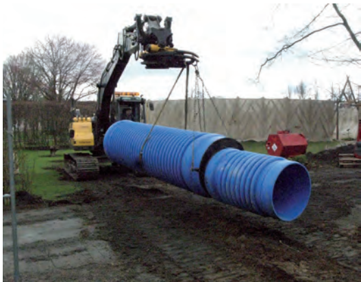
FIGUR 7. Rosenlunds park. Ventilationstrumman med en diameter på 1000 mm lyfts fram till schaktet. Foto: Claes Pettersson, JLM.
