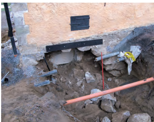
FIGUR 8. Rosenlunds herrgård. En genomföring avsedd för ventilationstrumman har utförts i källarmuren. Trots vissa praktiska problem vilka gjorde att hålet blev avsevärt större än beräknat. Foto: Claes Pettersson, JLM.
