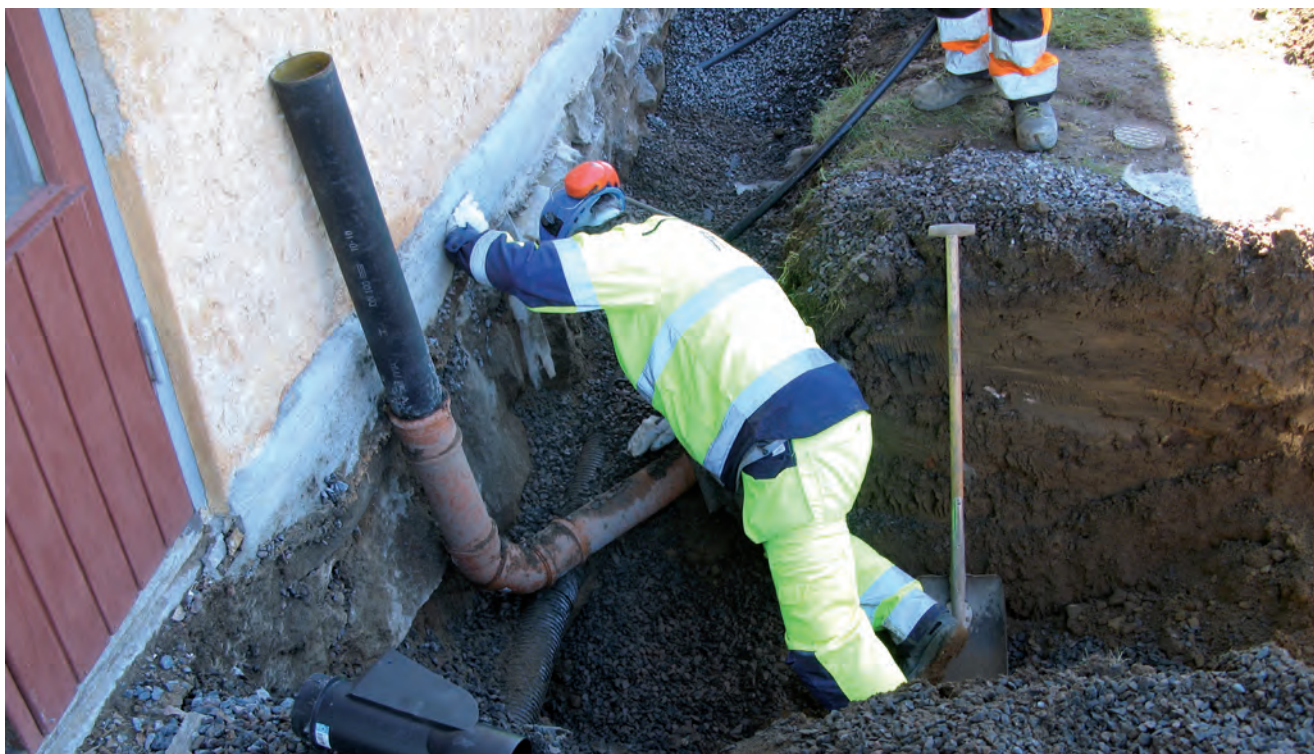
FIGUR 20. Delyta 4 - det sent påkomna tillägget i planeringen där vatten och avlopp skulle anslutas via ett genombrott i husets västra grundmur. Foto: Claes Pettersson, JLM.
