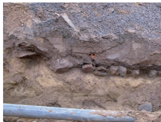
FIGUR 15. Parti av kullerstensläggning, påträffad i fjärrvärmeschaktets södra kant. Till vänster syns det bevarade bottenskiftet i terrassmuren (större sten). Foto: Claes Pettersson, JLM.
