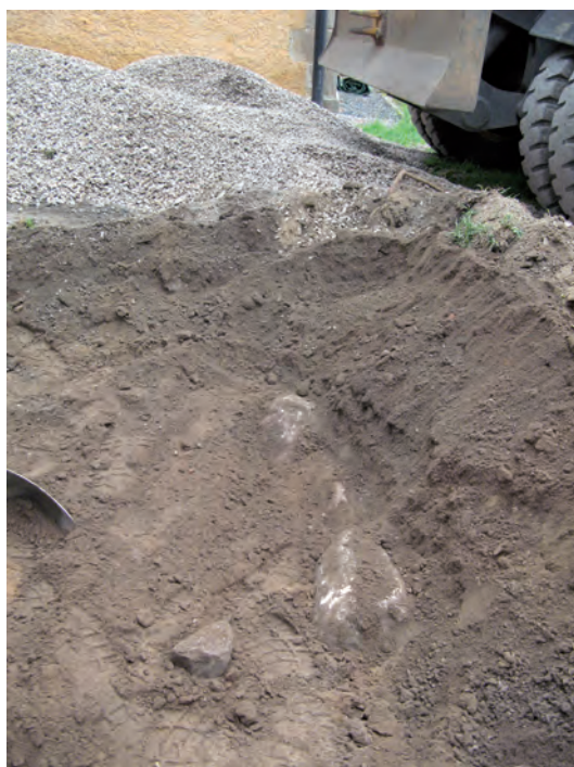
FIGUR 19. Stenrad i förlängningen av huvudbyggnadens västra fasad. Markerar skiljet mellan den kullerstenslagda gårdsytan och den grustäckta parterterassen. Lokaliserad, ej framrensad. Kvarligger intakt. Foto: Claes Pettersson, JLM.
