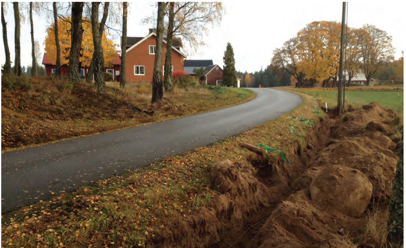
OVAN: Schaktning påbörjad från elstolpe väster om gravfältet. Foto från väster. NEDAN: Schakt med gravfält till vänster om vägen. Foto från sydväst.
