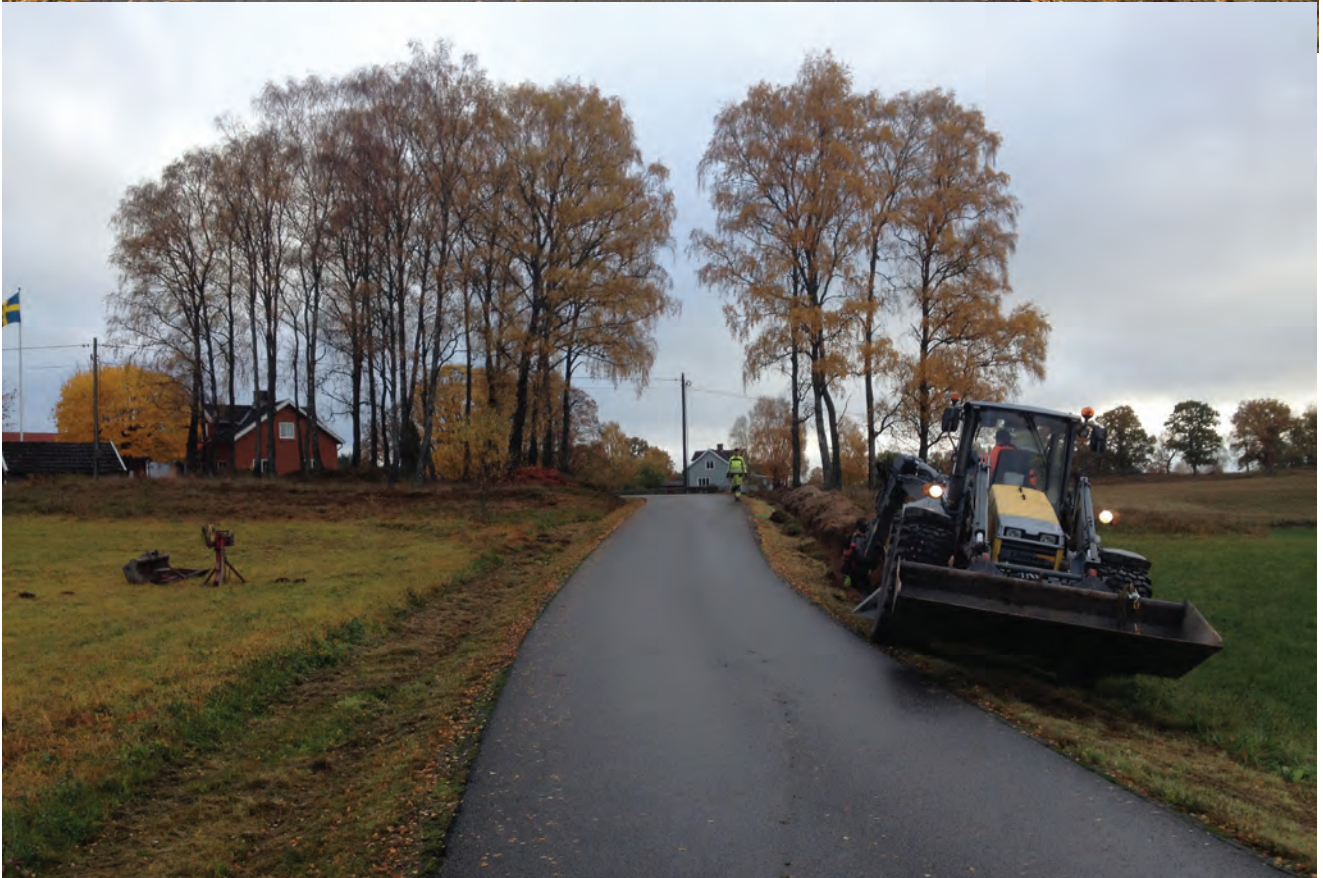
OVAN: Schakten på båda sidor av vägen söder om gravfältet. Foto från sydväst. NEDAN: Schaktning med gravfältet i bakgrunden. Foto från sydväst.
