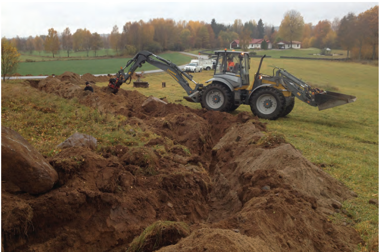
OVAN och NEDAN: Schaktning påbörjad från elstolpe väster om gravfältet. På grund av berg i dagen fick schaktet dras längs åkerkanten och därefter längs vägen söderut istället rakt väster över åkern. Foto från väster.
