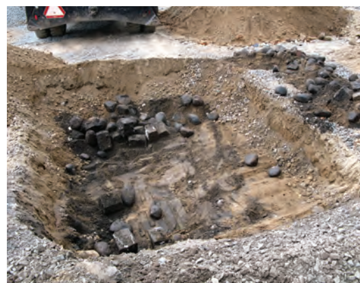
FIGUR 7. Hamnplanens kullerstensyta schaktas bort på platsen för en av dagvattenbrunnarna. Foto 2016: Claes Pettersson, JLM.
