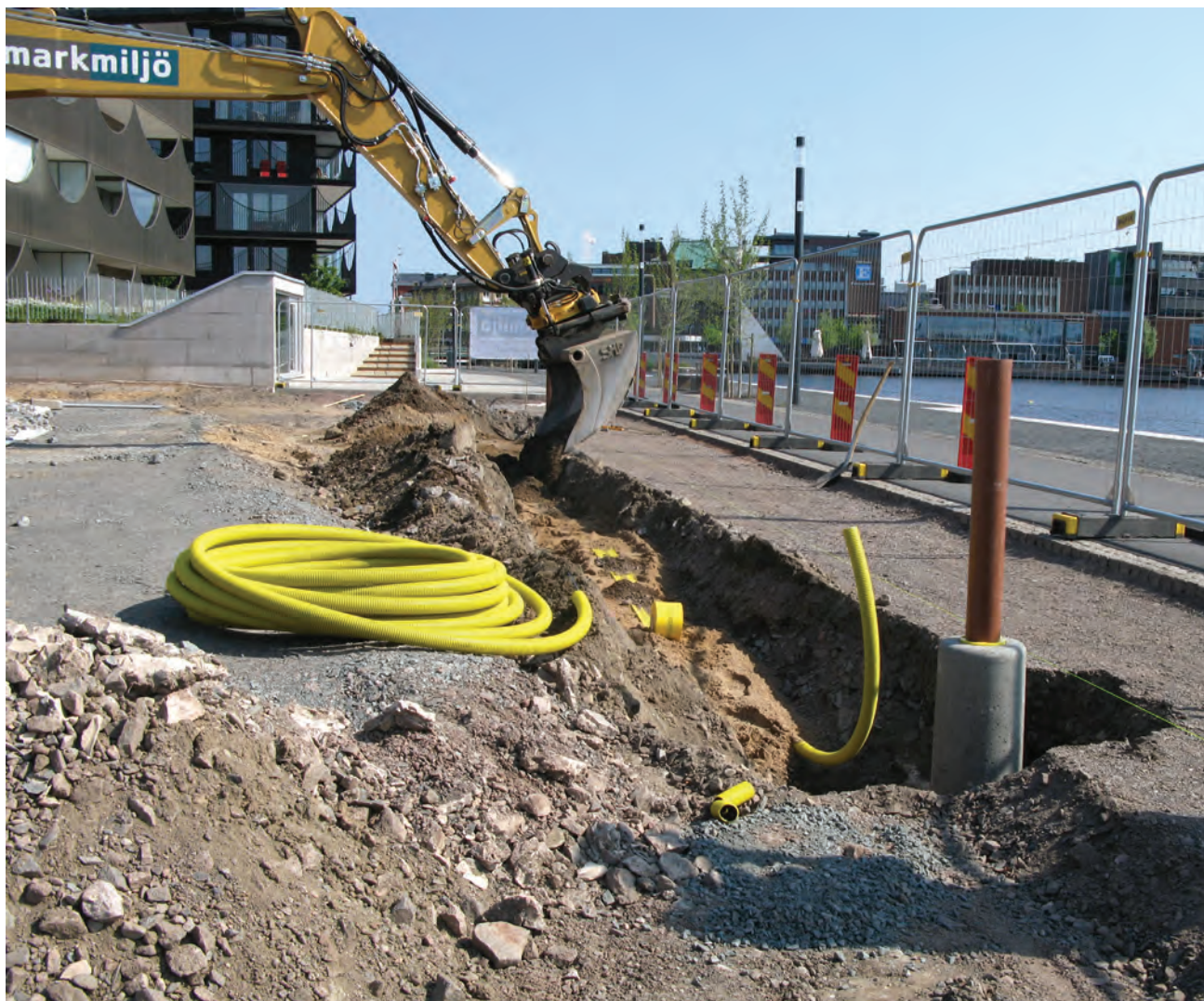
FIGUR 8. Utsättning av belysningsstolpar med tillhörande elkabel längs g/c-vägen vid Munksjön. Foto 2016: Claes Pettersson, JLM.
