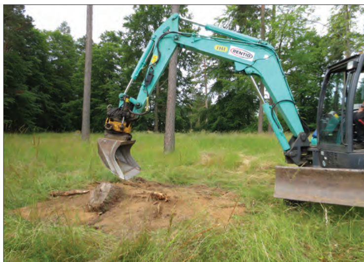
FIGUR 4. En av rotvältorna efter återställning.
