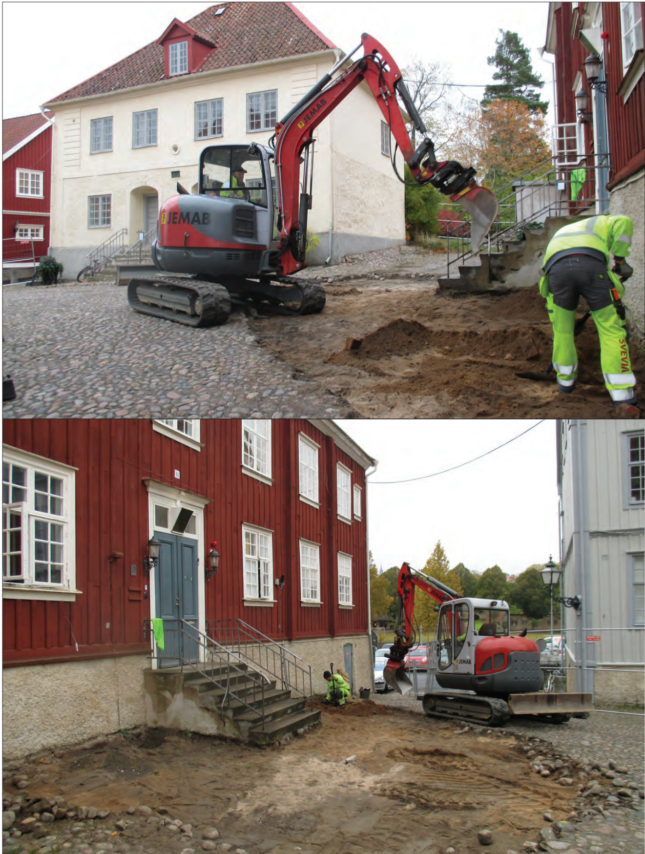
FIGUR 3A OCH 3B. Schaktning inom den västra delen av undersökningsområdet inne på hospitalsgårdens tomt. Merparten av området visade sig vara stört på grund av tidigare ledningsdragningar.
