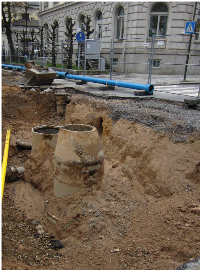
FIGUR 3. Det största schaktet i väster i krysset Skolgatan/Vallgatan med den påförda sanden och delar av äldre brunnar. Foto från nordväst.
