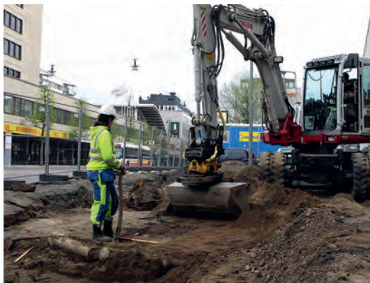
FIGUR 5. Schaktningsarbete i början av undersökningarna. Det framgår tydligt hur begränsad den tillgängliga arbetsytan egentligen var. Anna Kloö Andersson övervakar maskinens insatser. Foto: Anna Ödeén, JLM.
