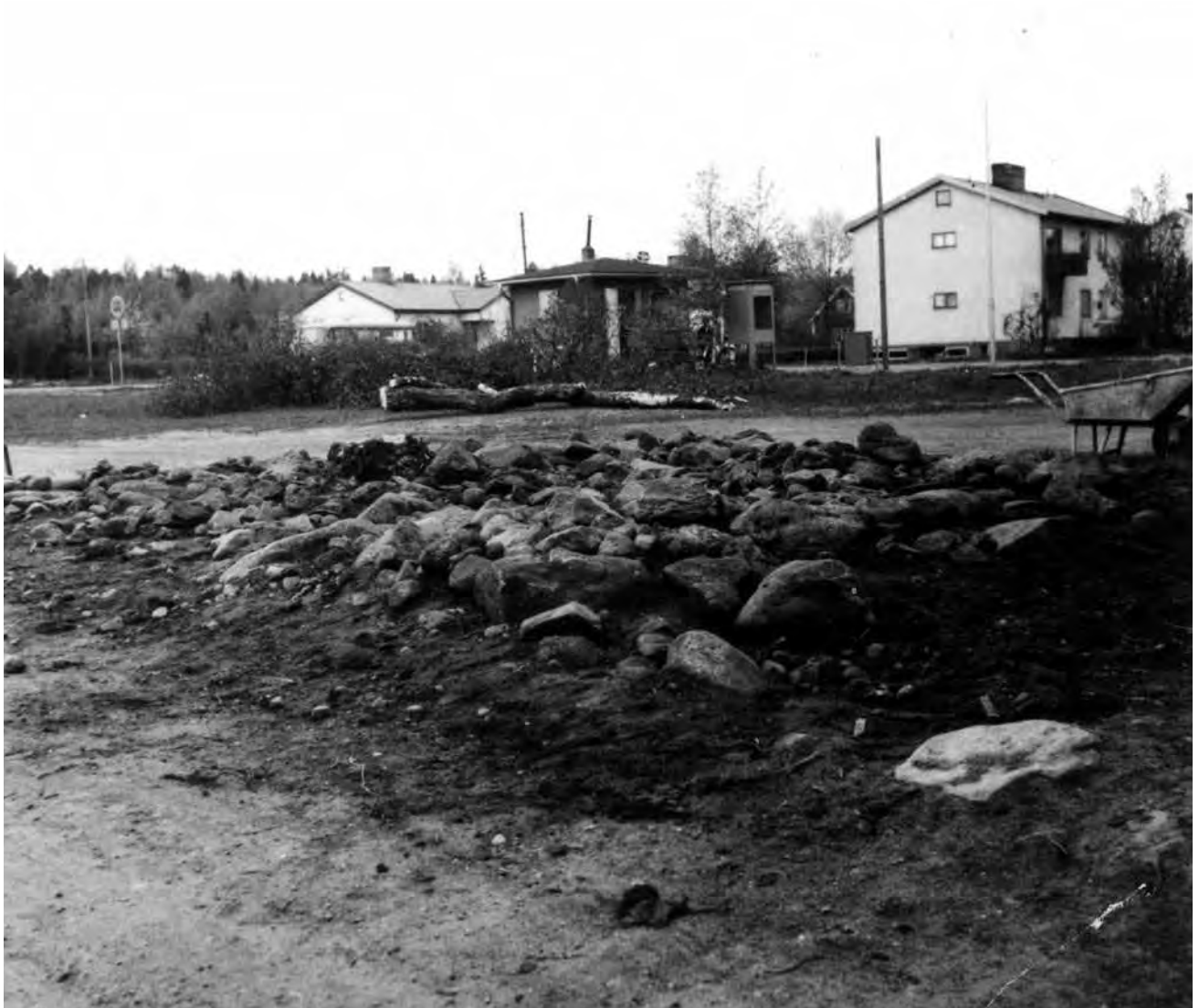
FIGUR 18. Stensättning nr 18 under utgrävning. Foto från väster Margaretha Linderöth 1965.
