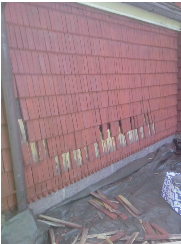
På korets norra fasad byttes ett antal röt- skadade spån. Foto: Hälsinge Takspån.
