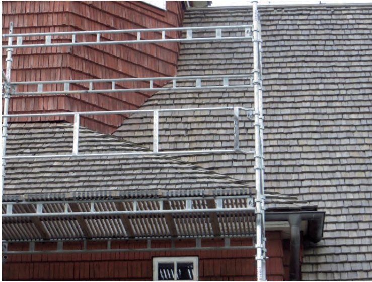
Mötet mellan tak och torn, inför arbetenas start.
