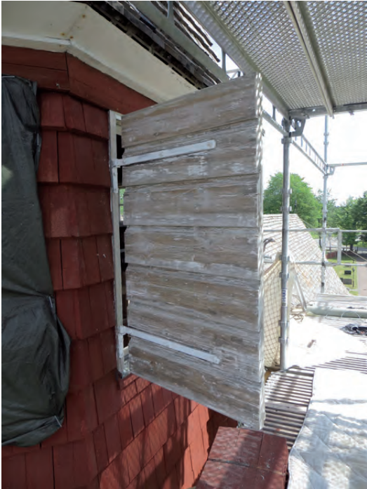
Under arbetets gång, färgen är borttagen på ljudluckan.
