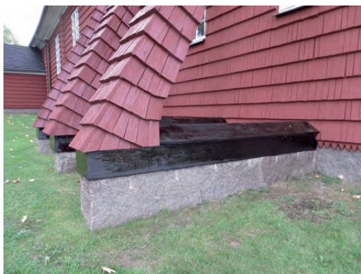
Täckbrädorna över stödbenens syllar tjärströks.
