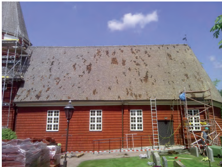
Byte takspån, södra takfallet. Foto: Hälsinge Takspån.
