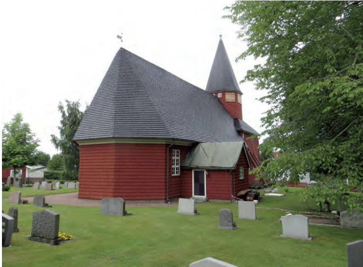
Pågående arbeten, långhusets och tornets tak är tjärade, omläggning pågår av sakristians tak.
