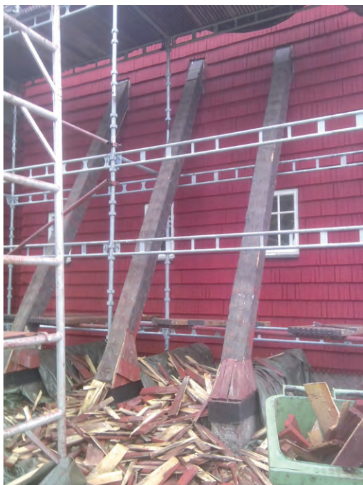
Rivning av spån, stödbenen norra fasaden. Foto: Hälsinge Takspån.
