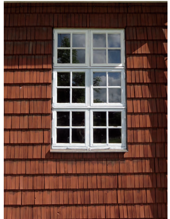
Ett av långhusets fönster före åtgärd.
