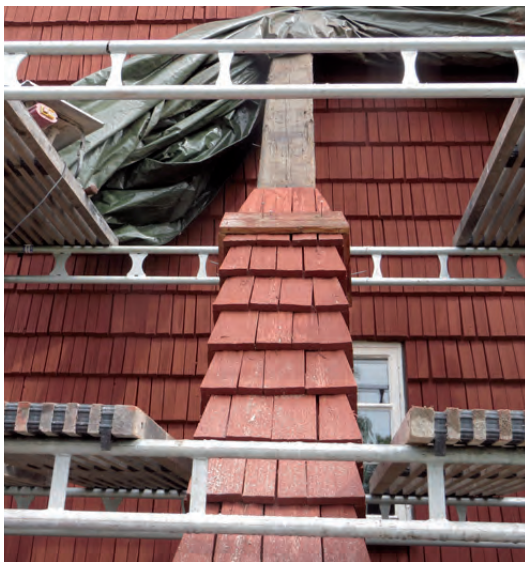
Detalj, pågående läggning av nya spån på stödbenen.
