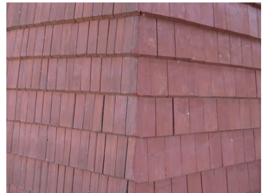
På tornets södra sida ersattes först spånen med spån bredare än befintliga. Skillnaden mot ursprungliga smalare spånen framgår tydligt mellan de två olika fasadsidorna.
