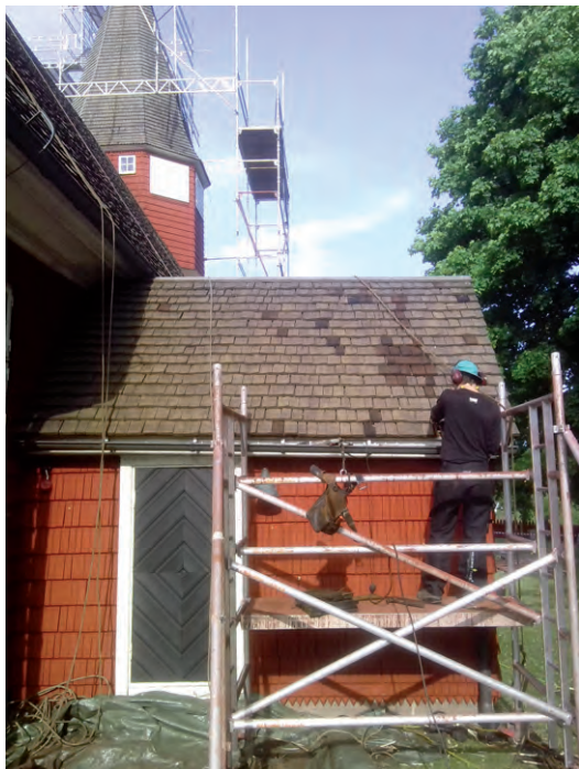
Byte av takspån, sakristians östra takfall. Foto: Hälsinge Takspån.
