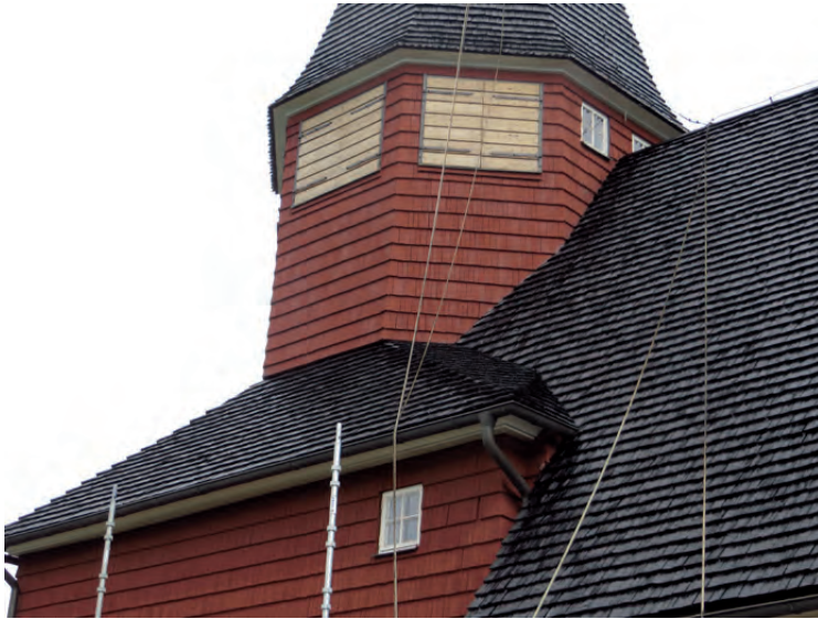
Takfallen är nytjärade, från söder. (Ljudluckorna är ännu inte tjärade.)
