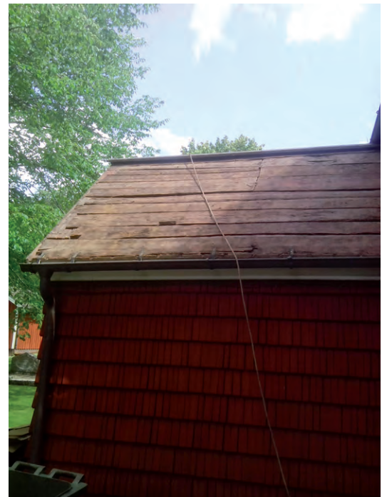
Takbotten sakristians västra sida. Foto: Hälsinge Takspån.
