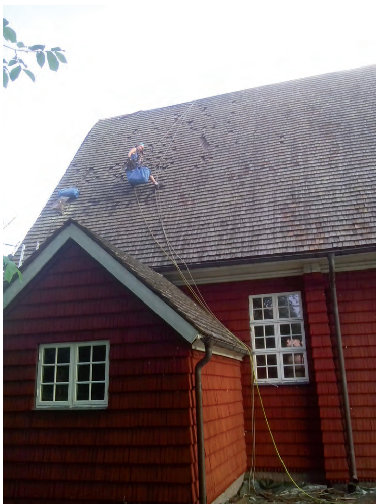
Byte av takspån norra takfallet. Foto: Hälsinge Takspån.
