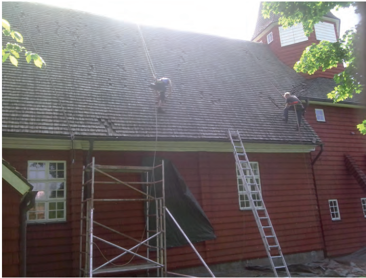
Pågående omläggning, norra takfallet. Foto: Hälsinge Takspån.
