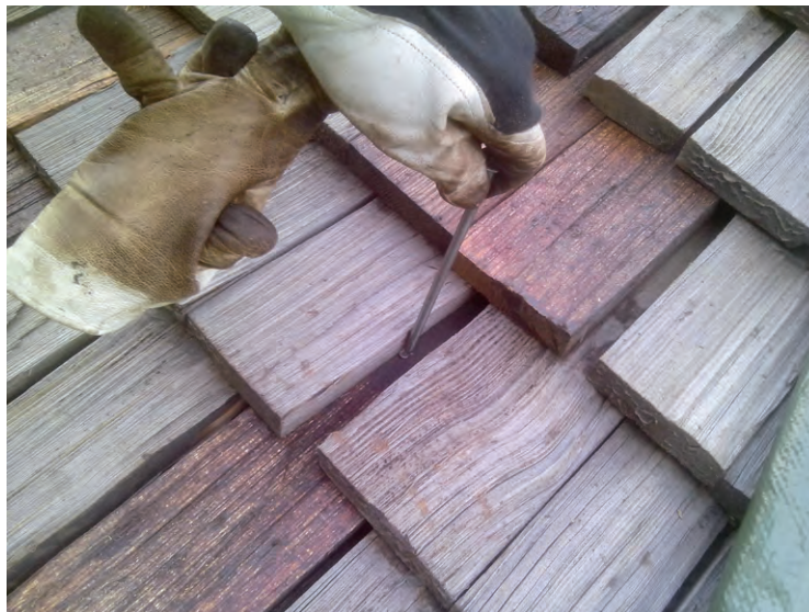
Detalj, spikning av ersättningsspån. Foto: Hälsinge Takspån.
