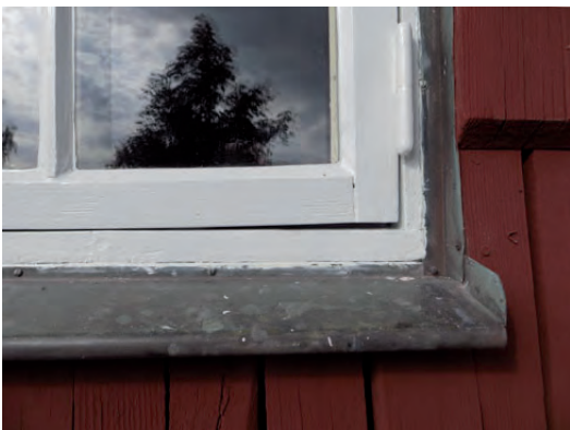
De färdiga fönstren, detalj.
