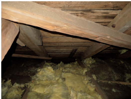
Isoleringen rakades initialt upp ur några fack ner mot takstolen för att förbättra ventileringen av vinden.
