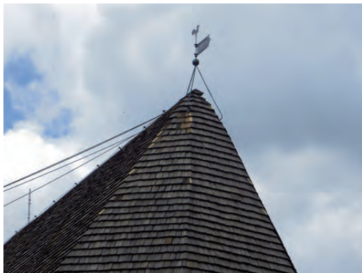
Den renoverade vindflöjeln är återmonterad.
