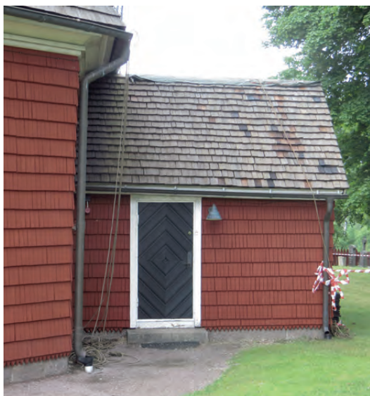
Bytta spån på sakristians östra takfall.
