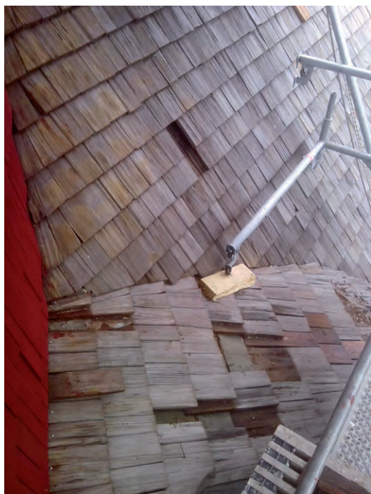
Detalj av bytta spån i vinkeln mellan tornet och långhusets tak, södra fasaden. Foto: Hälsinge Takspån.
