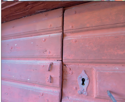
Kvarnens båda dubbelporlar från 1813 finns bevarade, varav den till kvarnkammaren är försedd med profilhyvlad panel, nyckelbricka och invändiga bandgångjärn i smide.
