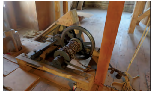
Uppfordringsverk för säckar i tredje våningen konstruerat av Oscar Jonsson.
