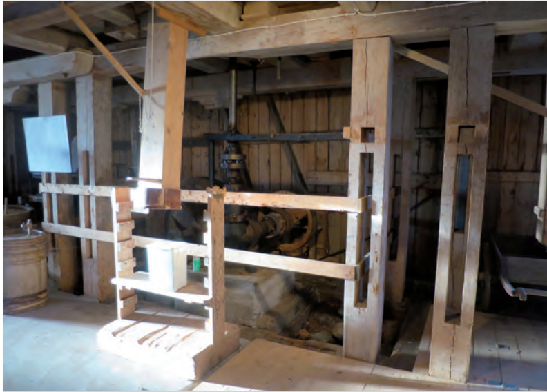
Hjulaxel och transsmission med vinkelkopplingen Volvo i underhuset. Äldre säckstol. Under golvluckan till höger finns hjulsgraven till det tredje kvarnverkets drivhjul bevarad.
