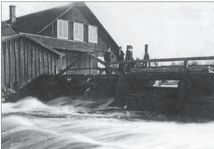
Dammfästet med sina luckor år 1914, alltså strax före övergången till turbindrift. Här syns en vinkellänga i den sågbyggnad som uppförts vid okänd tidpunkt i slutet av 1800-talet. Den har flakt tak och väggbeklädnad med lockpanel av okantade brädor. Bäckseda hembygdsförenings arkiv.
