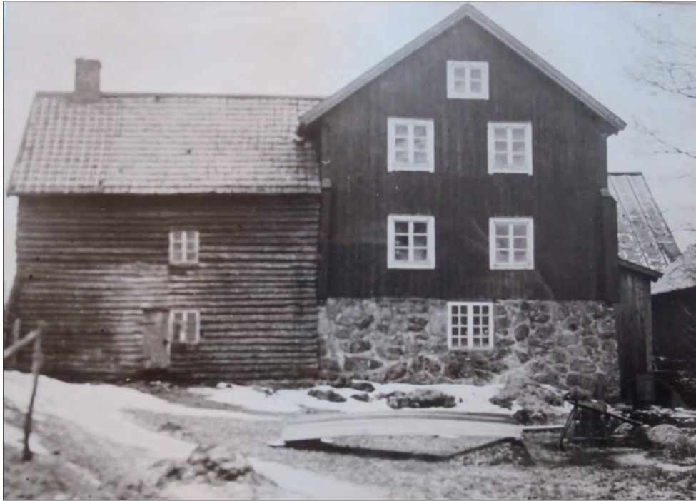
Kvarnen sedd från öster vid okänd tidpunkt i början av 1900-talet, dock före 1915. Här framträder det timrade hjulhuset från 1813. Den östra delen av kvarnen hade byggts på med en tredje våning och i samband härmed klätts in med en locklistpanel och fönsterfoder med nedskjutande ändar. De smårutade fönstren från 1813 hade 1867 satts in i underhuset. Bäckseda hembygdsförenings arkiv.
