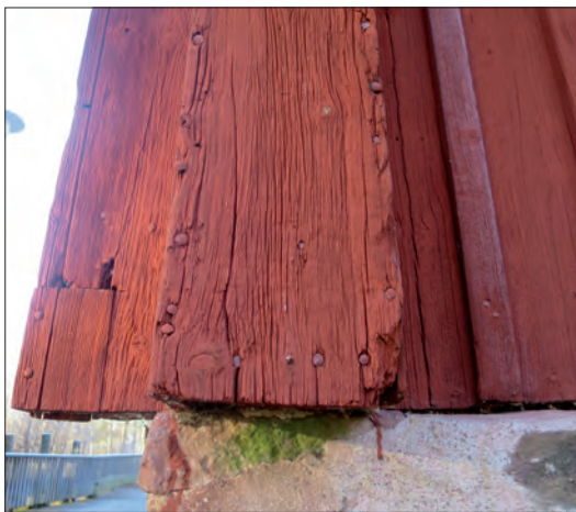
Äldre knutbrädor med smidd spik på kvarnen östra del, sannolikt från 1867.
