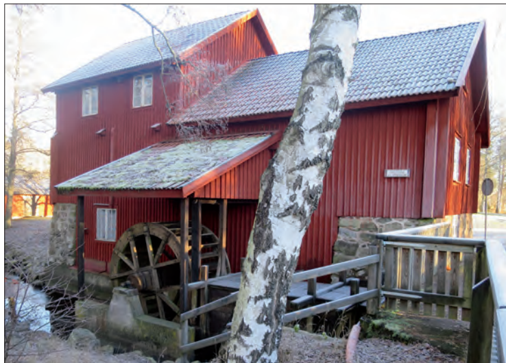
Vattenhjulet och dess skärmtak återskapades 1985. Skärmtaket är inte helt identiskt med sin föregångare. Med vilken noggrannhet vattenhjulet är rekonstruerat har inte kunnat avgöras, men det faktum att den tidigare mjölnaren Nils Svensson deltog i arbetet bör borgat för kunskapsöverföringen.
