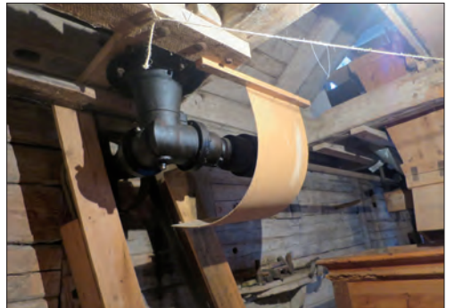
En av de bevarade vinkelkopplingarna konstruerade av Oscar Jonsson.
