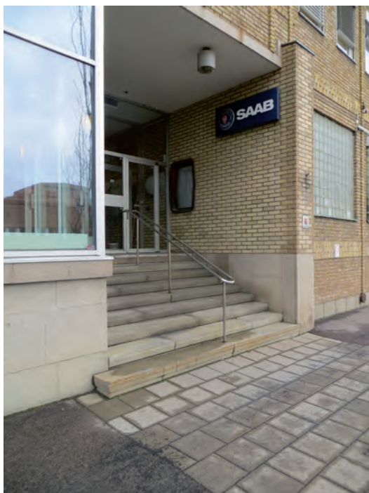
Fabriksbyggnadens tidigare huvudentré.
