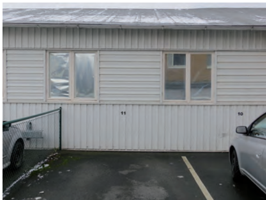
Detalj av barackens plåtfasad.
