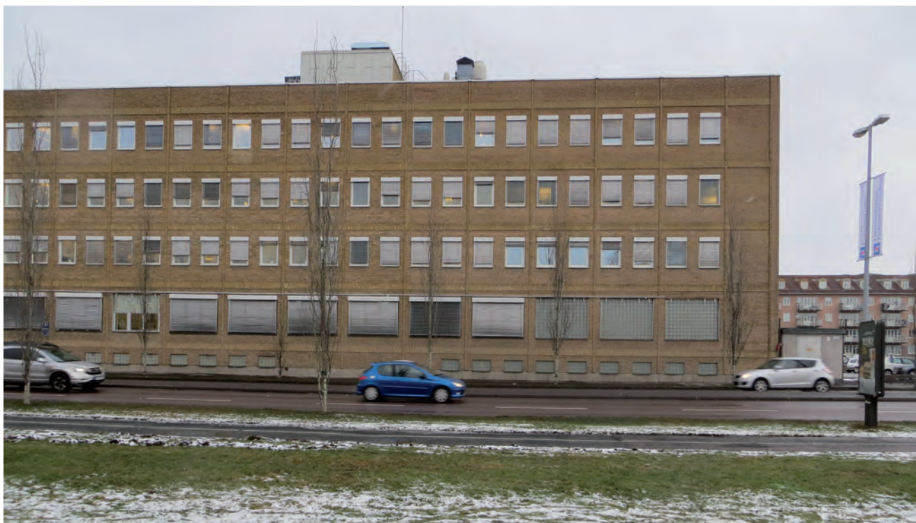
Del av fabriksbyggnadens södra fasad. Precis i höjd med den blå bilen går skarven mellan fabriken's äldsta del och tillbyggnaden från 1962.
