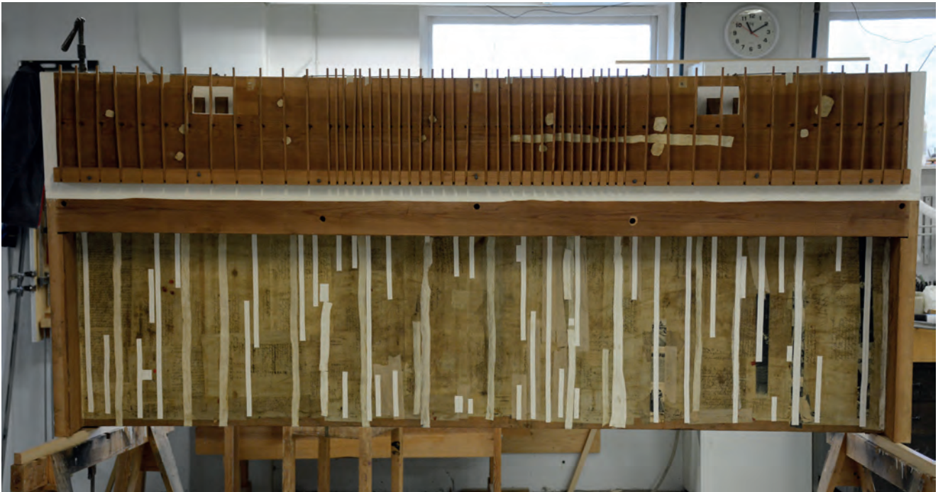
Väderlådans undersida efter restaurering med kompletterande skinntätningar. Foto: R. Gullbrandsson. Under side of wind chest after restoration.
