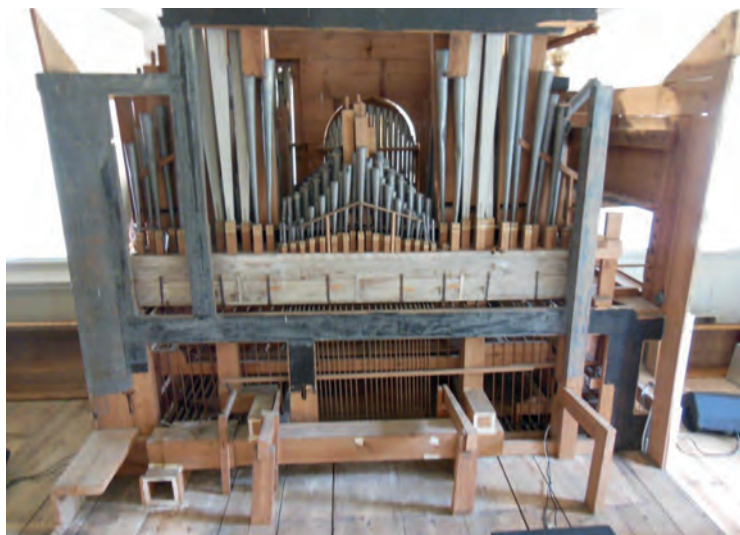
Befintliga luftkanaler och spärrventil är sannolikt från 1865. Foto: Bergenblad & Jonsson. Wind channels.
