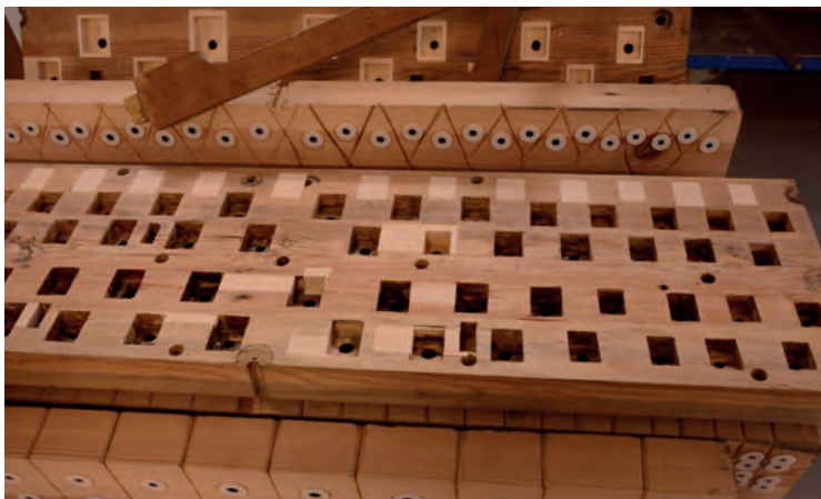
Rörverksstock efter restaurering. Foto: R. Gullbrandsson. Reed stock after restoration.
