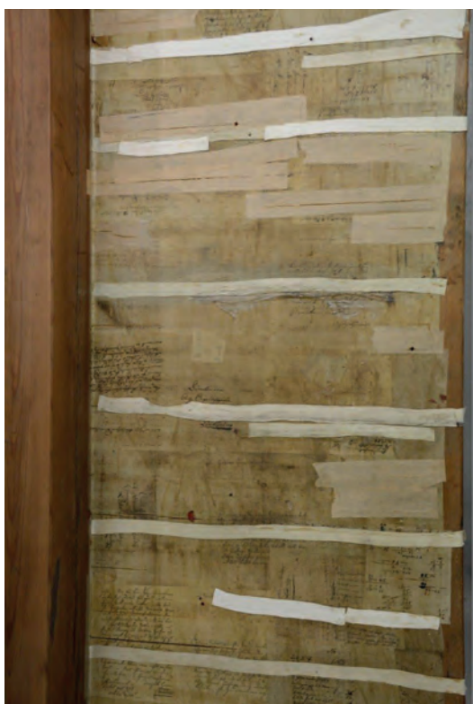
Korrespondens till och från Schiörlin, använd av denne till att tätat väderlådans undersida. Foto: R. Gullbrandsson. Correspondance of Schiörlin, which he has glued on to the under side of the wind chest.
