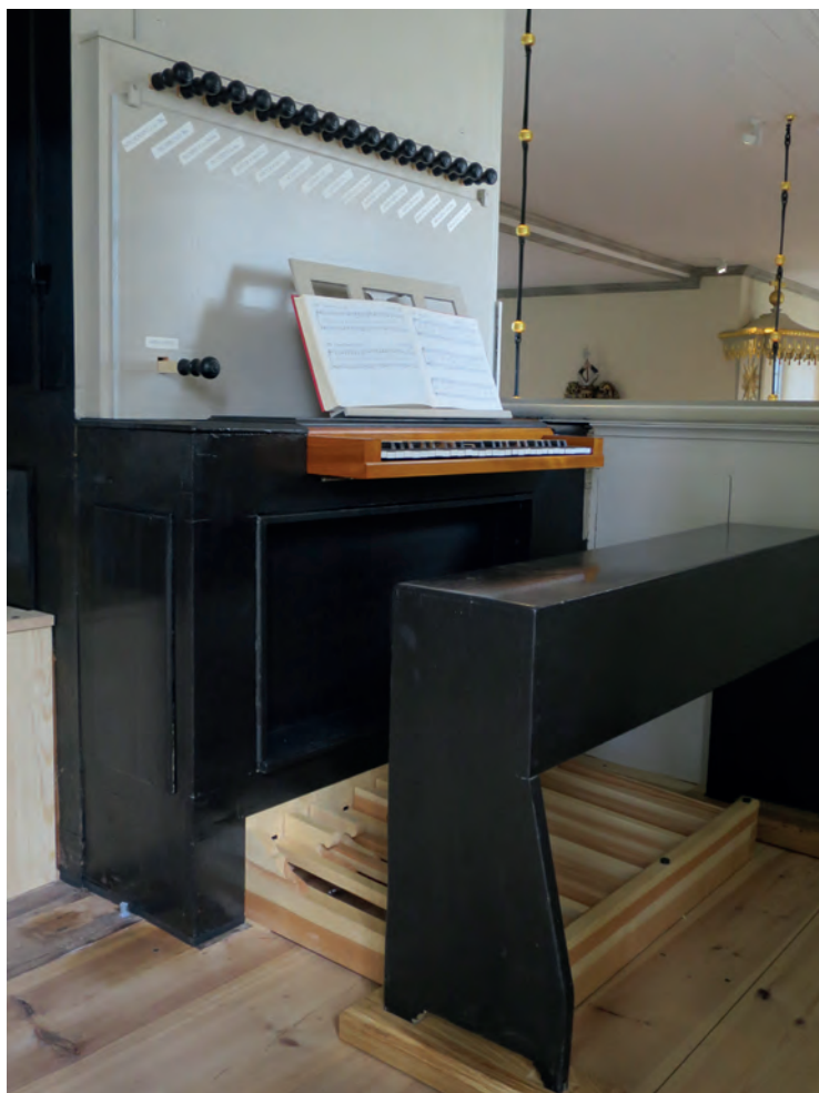
Rekonstruerad bihangspedal med förlaga från Ekebyborna kyrka. Den ursprungliga orgelpallen har fått svart kulör ovanpå äldre färgskikt och kompletterats med lösa träblock för att reglera sitt höjd. Foto: R. Gullbrandsson. Reconstructed pull-down pedal. The original bench is brought back, painted black on top of more recent surfaces of colour and completed with loose pieces to adjust the level.
