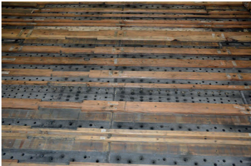
Väderlådans slejfbänor före restaurering. Foto: R. Gullbrandsson. Slider bed before restoration.
