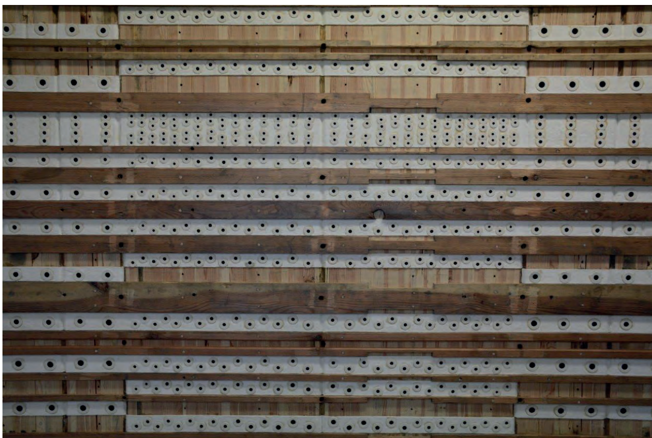
Slejfbänorna efter rengöring och montering av nya skinn och filtringar. Foto: R. Gullbrandsson. Slider bed after restoration.
