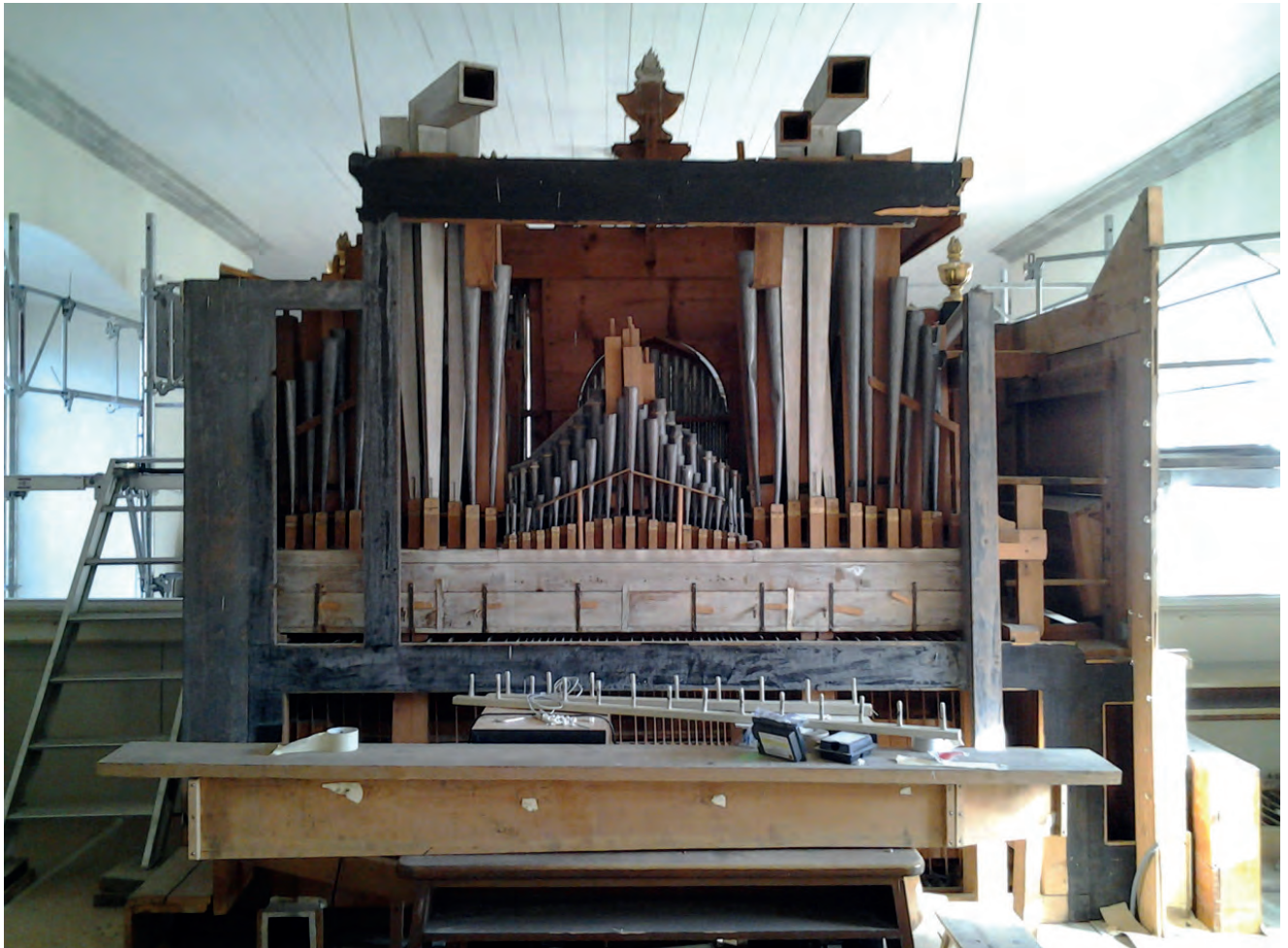
Orgelhuset sett bakifrån 2014 efter rivningen av Grönvallorgeln. Baksidans ramverk har kvar sin svarta originalbemålning. Till höger ses det till hälften inbyggda (1865) ursprungliga spelbordet. Foto: R. Gullbrandsson. The organ from behind in 2014 after the removal of the Grönvall organ from 1951. The framework still bear the original black colour. To the right, the original console is seen, partly concealed in 1865.
