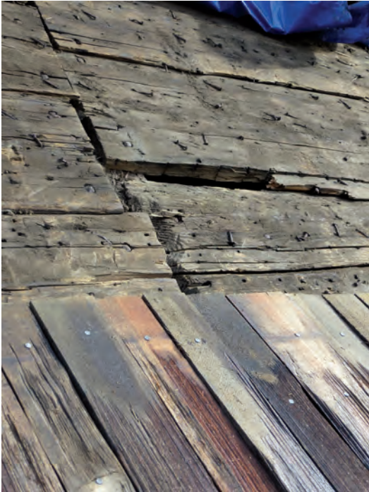
Rivning av spån och läggning av nya pågär. Glipor som denna åtgärdades inte eftersom man ändå kunde erhålla fullgott underlag att spika fast de nya spånen i.
