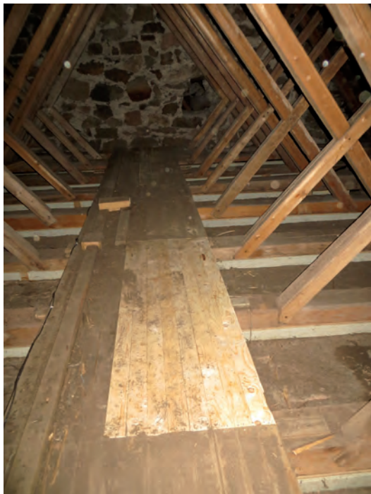
Långhusets vind var försedd med en brygga av återanvänd pärlspontpanel. Partiella rötskador lagades i med nytt virke.
