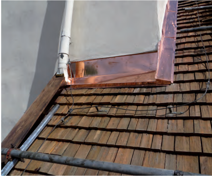
Ovan: Plåtavtäckningen mot tornväggen inför arbetena. Ovan till vänster: Den nya plåtavtäckningen samt den på takfallet liggande röret från tornets stuprör. Här har detta rör täckts av en bräda för att smälta in.
