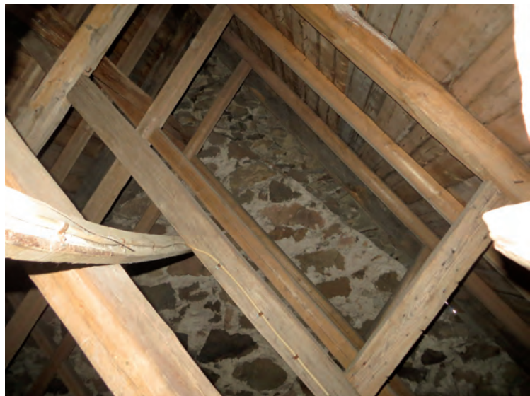
Ovan: Gaveln på sakristian där man kan ana taksparrens ben som ligger strax bakom putsen. Till höger: Långhusvinden med det murade gavelröset där man kan se spår efter ett flackare tak. Nedan: Röda spår i underliggande putsskikt på korets södra vägg över sakristian.
