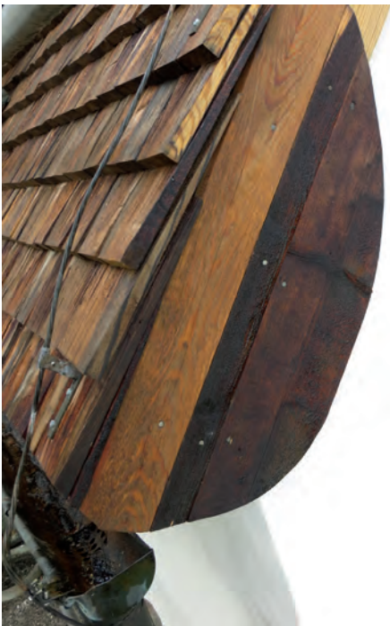
Takkanterna, här på sakristian, gjordes så att spånen rår över vindskivorna eftersom läckage tidigare förekommit med den befintliga konstruktionen.
