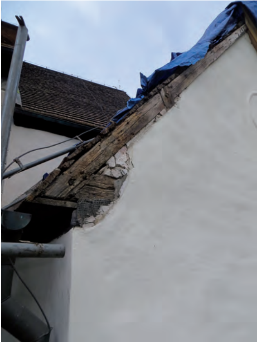
Ovan: Gaveln på sakristian där man kan ana taksparrens ben som ligger strax bakom putsen. Till höger: Långhusvinden med det murade gavelröset där man kan se spår efter ett flackare tak. Nedan: Röda spår i underliggande putsskikt på korets södra vägg över sakristian.
