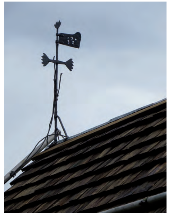
Vindflöjlarna på ändarna av långhusnocken fick göras om så att de kunde fästas i den nykonstruerade nocken.
