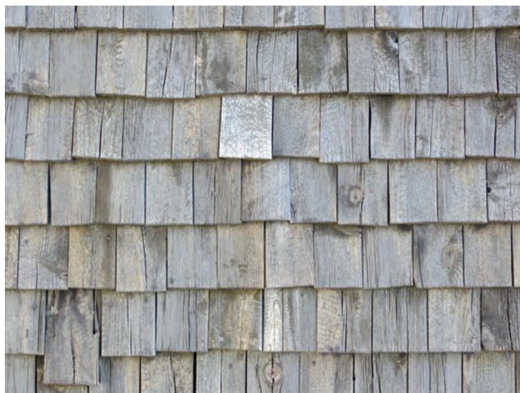
Ovan: Rivna spån. Till vänster: Detalj av den befintliga spåntäckningen.
