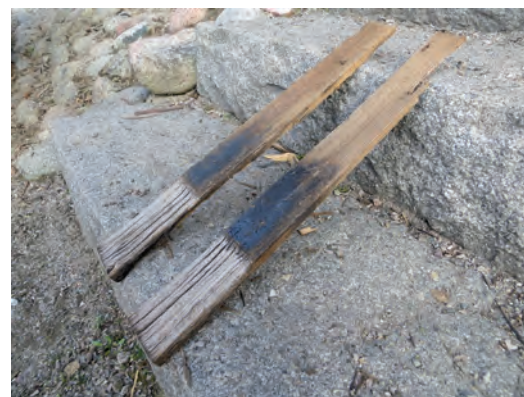
Ovan: Rivna spån. Till vänster: Detalj av den befintliga spåntäckningen.
