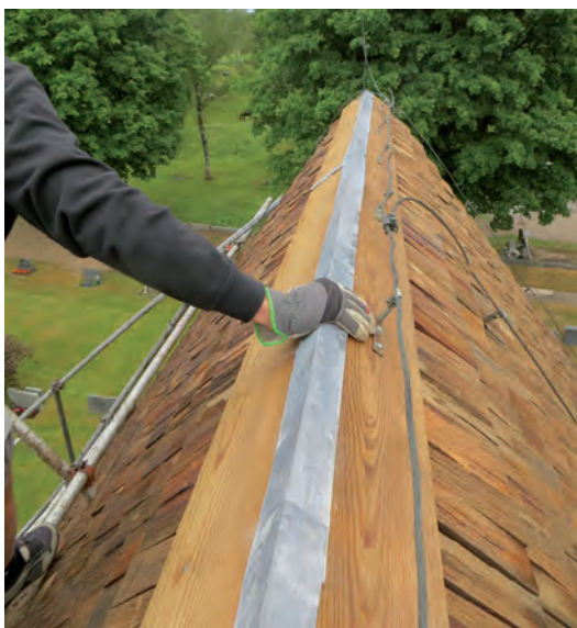
Den nya nocken konstruerades med två brädor och en remsa av blyplåt som täcker skarven dem emellan.
