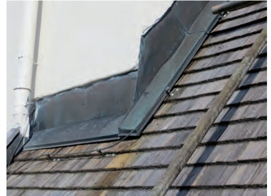
Ovan: Plåtavtäckningen mot tornväggen inför arbetena. Ovan till vänster: Den nya plåtavtäckningen samt den på takfallet liggande röret från tornets stuprör. Här har detta rör täckts av en bräda för att smälta in.
