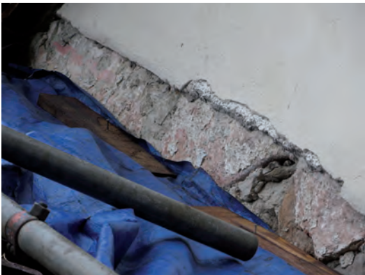
Ovan: Gaveln på sakristian där man kan ana taksparrens ben som ligger strax bakom putsen. Till höger: Långhusvinden med det murade gavelröset där man kan se spår efter ett flackare tak. Nedan: Röda spår i underliggande putsskikt på korets södra vägg över sakristian.
