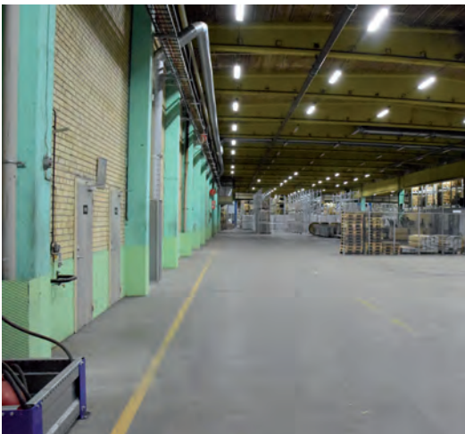
Den norra innerväggen i produktionshallen kläddes med gult fasadtegel.
