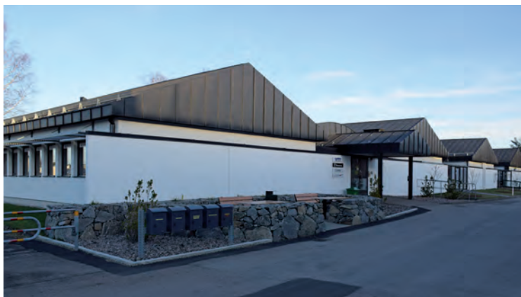
Kontorslängorna hålls samman och bildar en enhet genom de på kant stående vita betongelementen.
