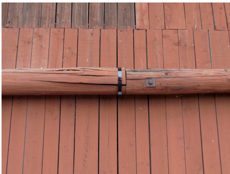
Den spruckna gördellisten på den södra fasaden drogs ihop med ett järnband.
