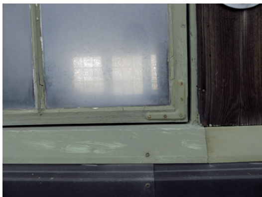
Detalj fönster i lanterninen före åtgärd.
