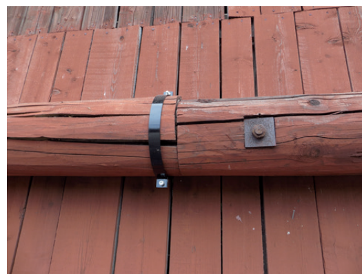
Den spruckna gördellisten på den södra fasaden drogs ihop med ett järnband.
