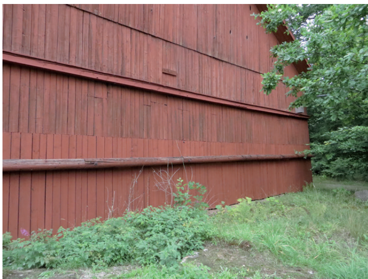
Kolladans östra vägg med den lagade gördellisten, norra delen.
