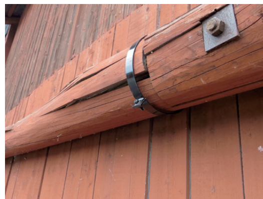
Till vänster: Översikt över den östra väggen med den lagade övre gördellisten.
